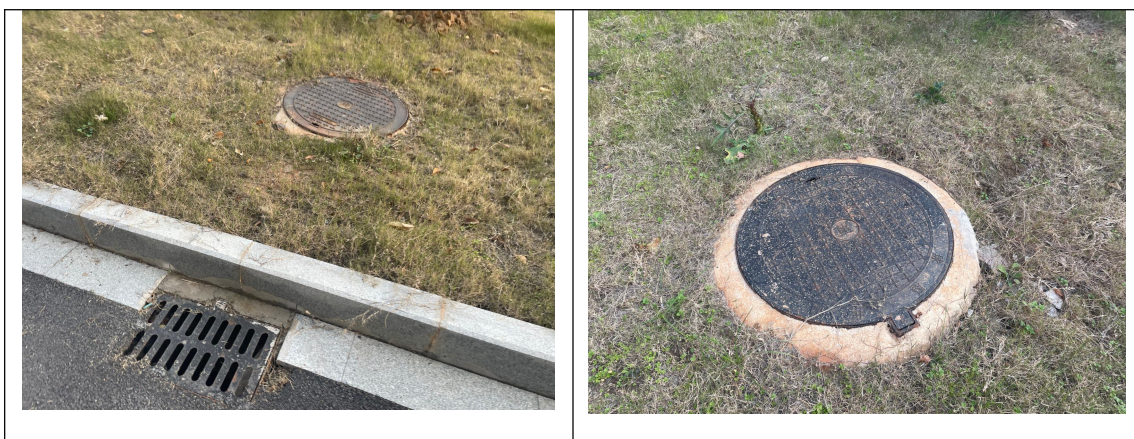
雨水口雨水井运行情况
