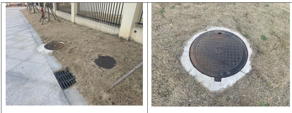
雨水口雨水井运行情况
