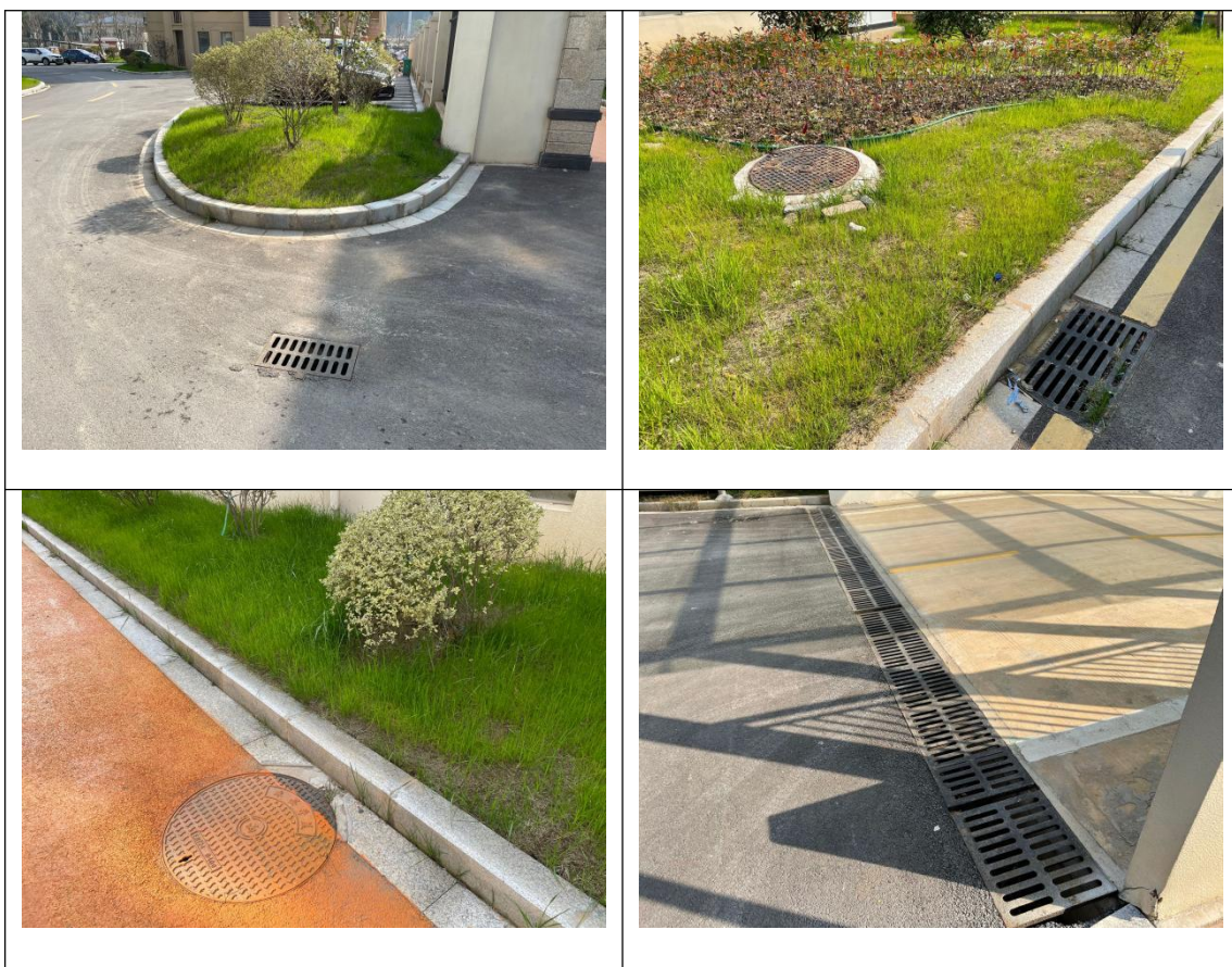
雨水口雨水井运行情况
