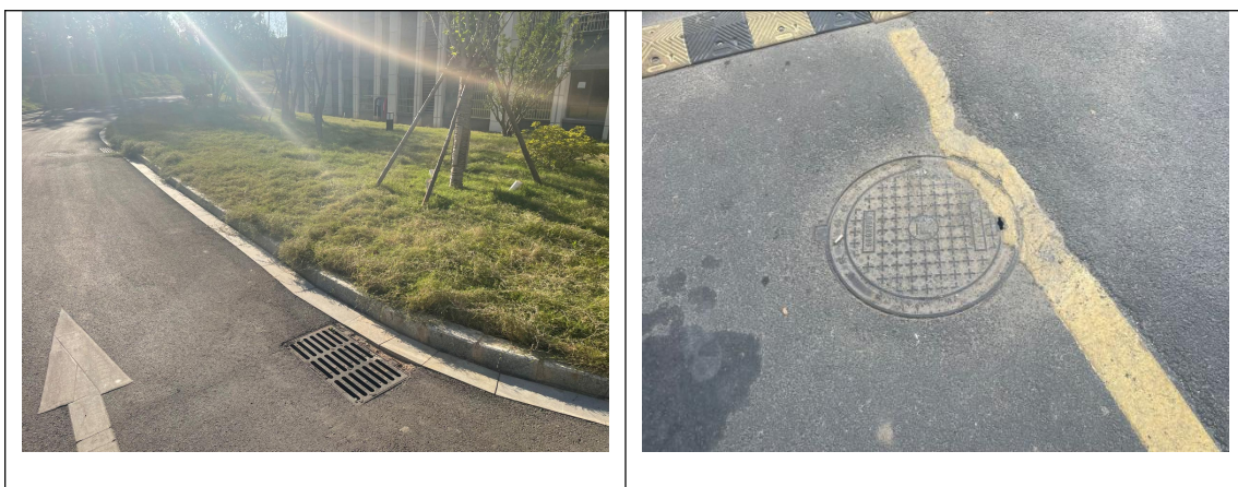
雨水口雨水井运行情况
