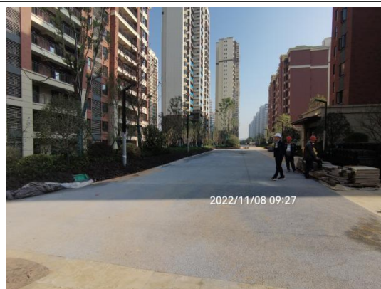
2022 年第四季度植物措施施工后
