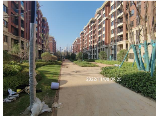
2022 年第四季度植物措施施工后
