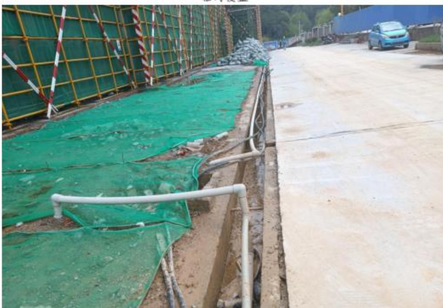
临时覆盖及场地排水沟
