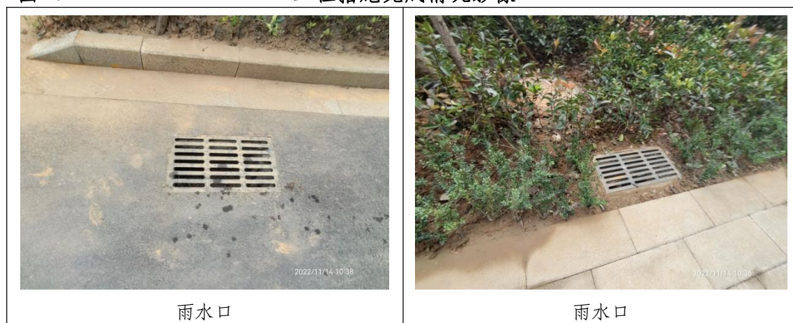
图 4.1-1 工程措施完成情况影像
