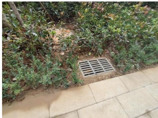
2022 年第四季度雨水口运行情况
