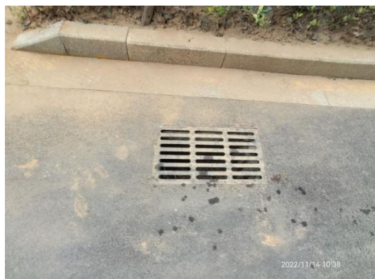
2022 年第四季度雨水口运行情况
