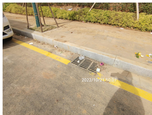
2022年第四季度雨水口运行情况
