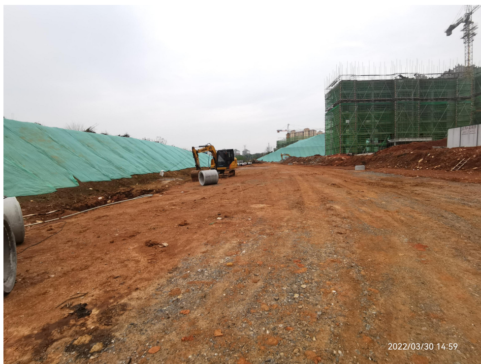
(施工过程中边坡重点监测部位)
