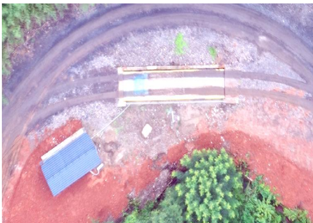
地磅及值班室现场照片
