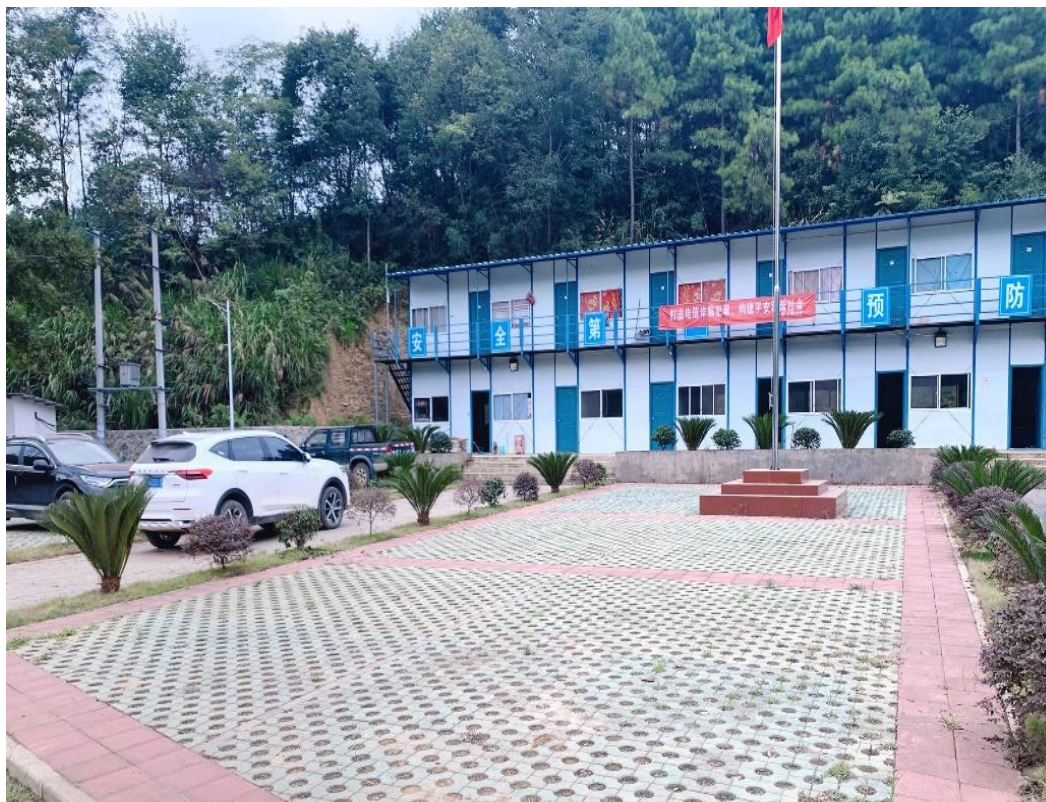
办公楼现场照片
