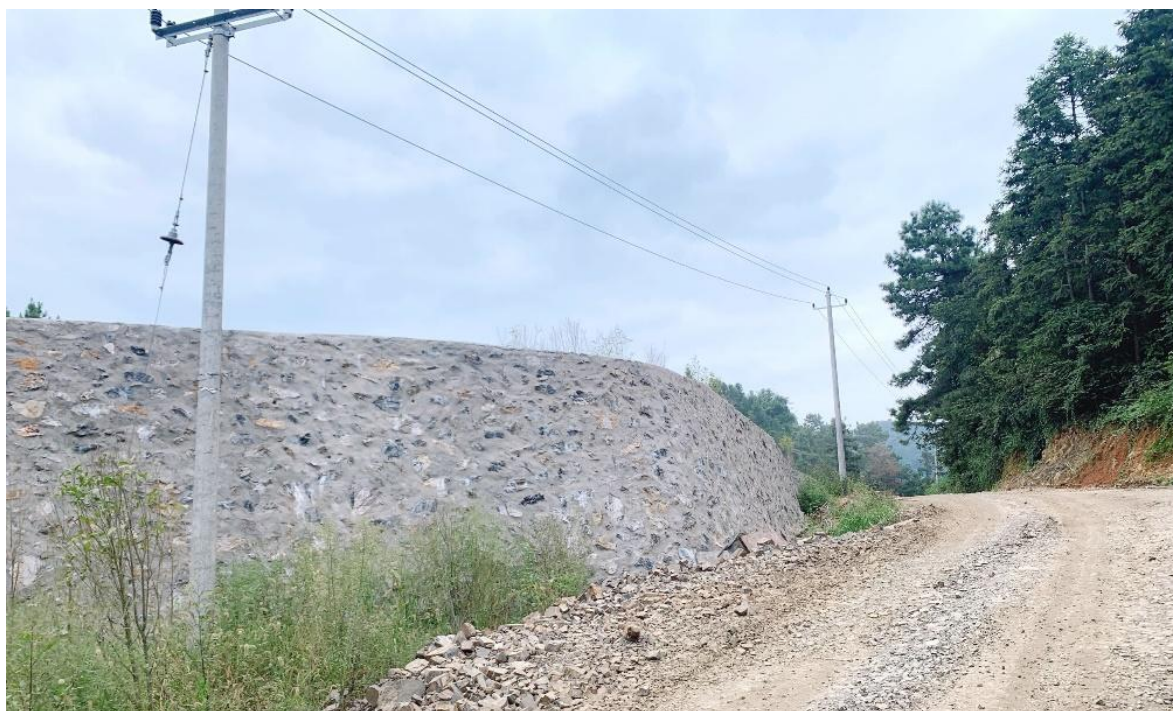
工业场地挡土墙现场照片
