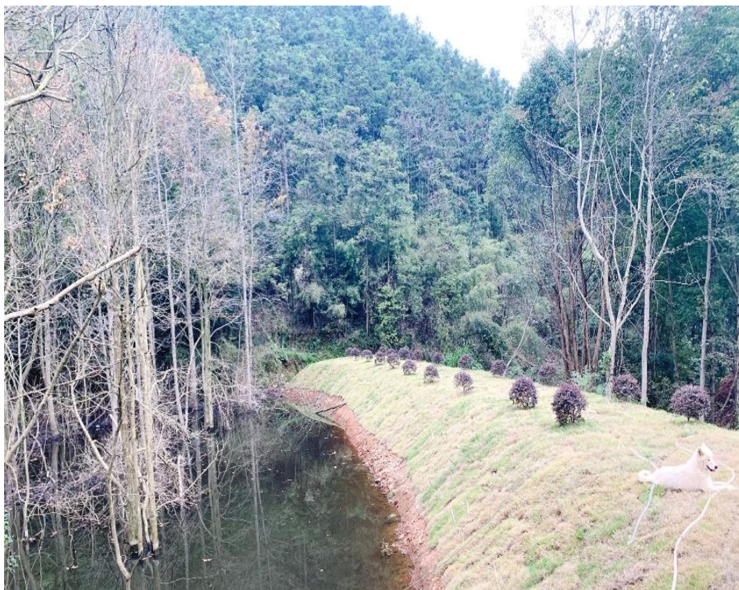
雨水沉淀净化池现场照片
