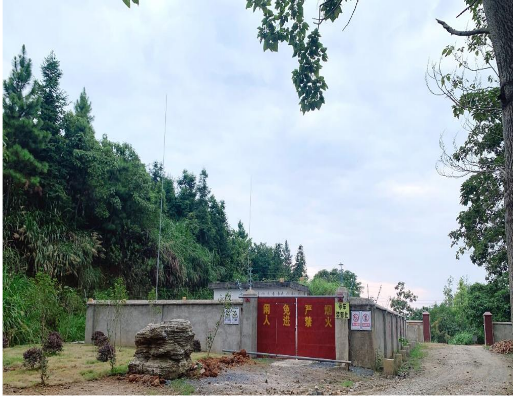
炸药库现场照片
