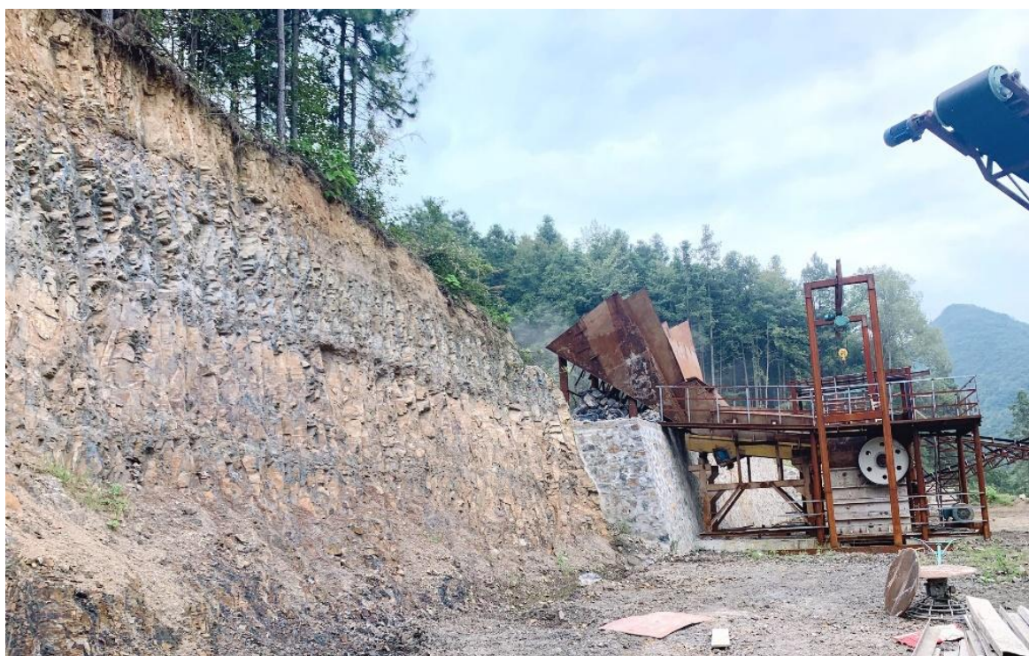
工业场地挡土墙现状照片
