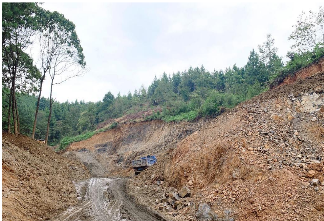
南副斜井现场照片
