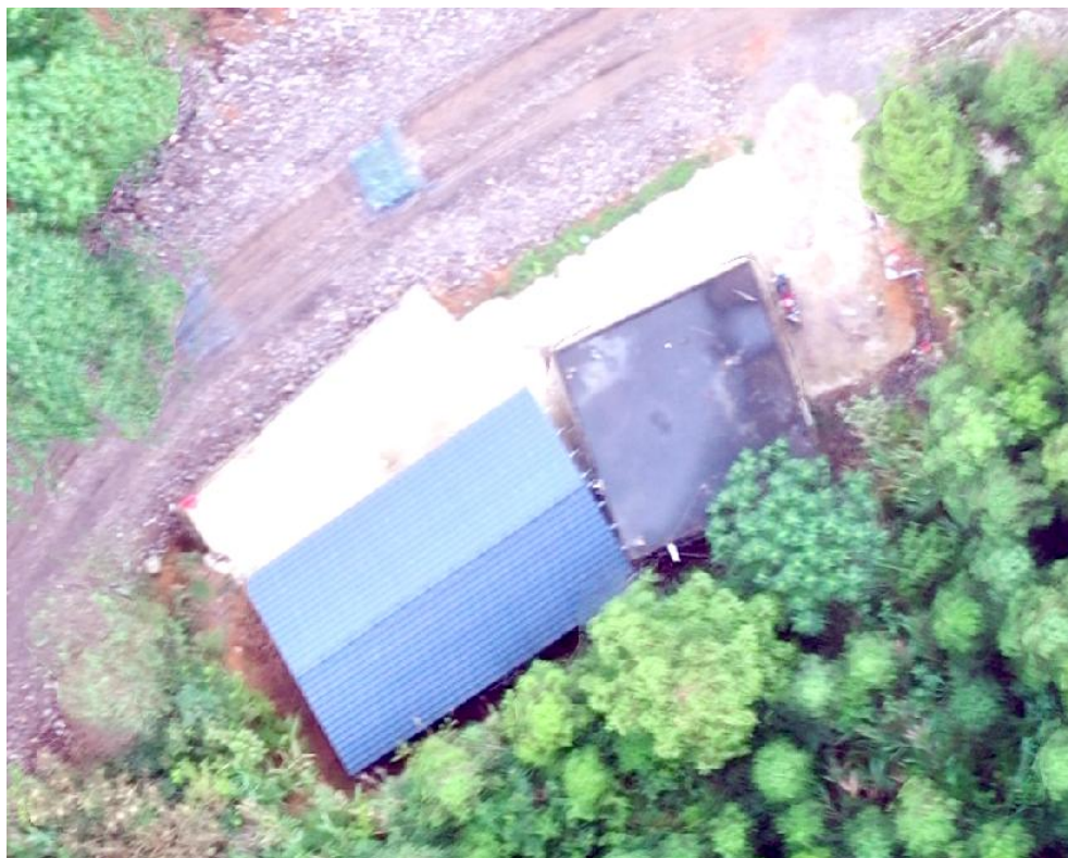
门卫室现场照片
