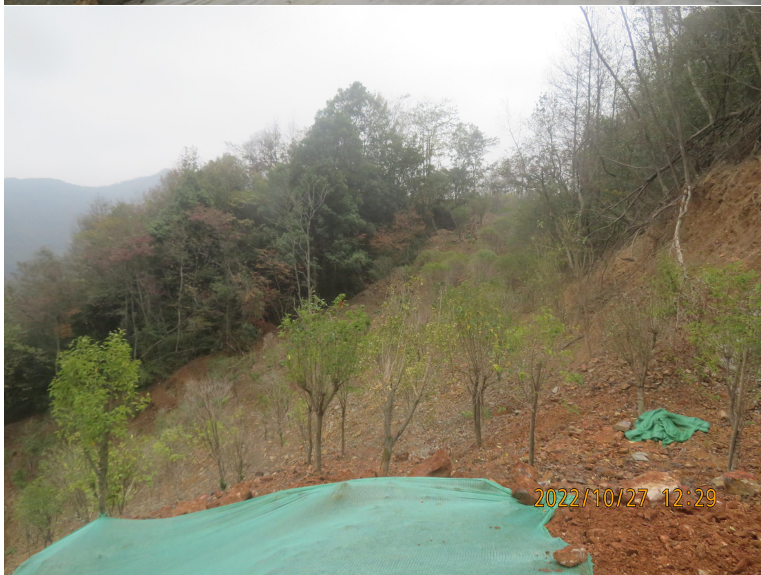
（边坡及排土场重点监测部位）
