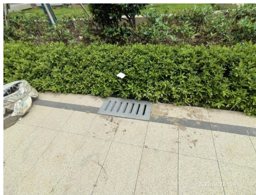
2022 年第二季度雨水口运行情况
