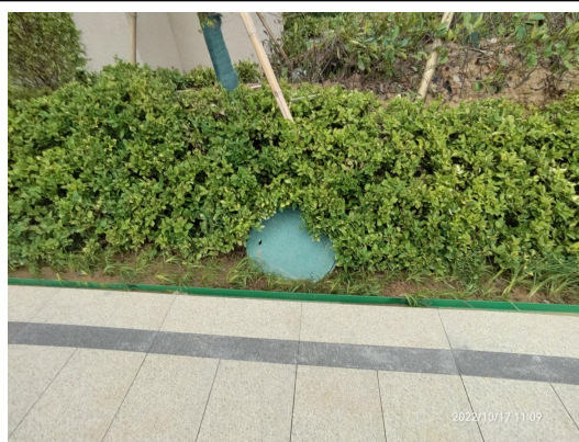
2022 年第四季度雨水井运行情况
