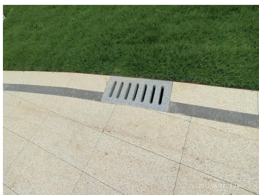
2022 年第二季度雨水口运行情况
