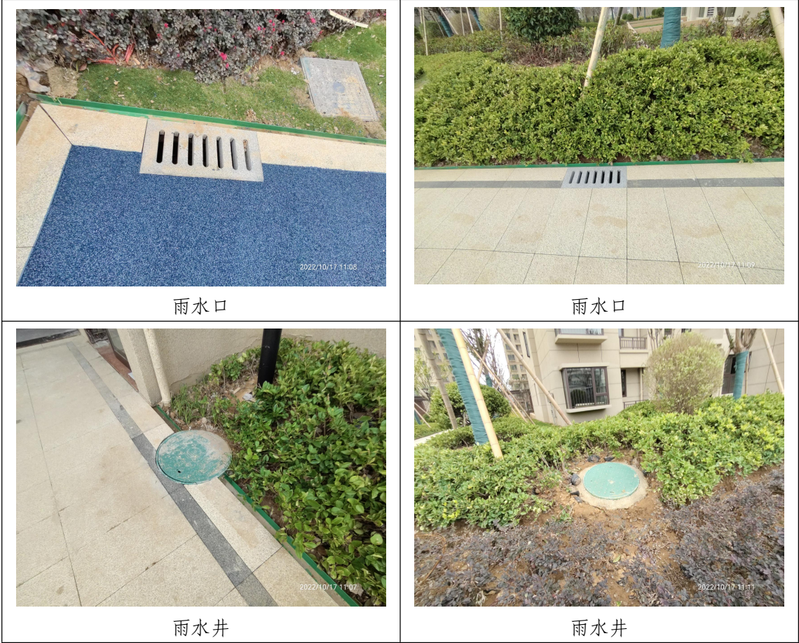
图 4.1-1 工程措施完成情况影像
