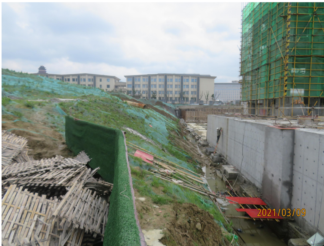
(施工过程中地下室开挖、临时堆土及边坡重点监测部位)
