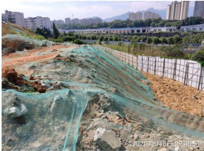
临时覆盖及围挡
