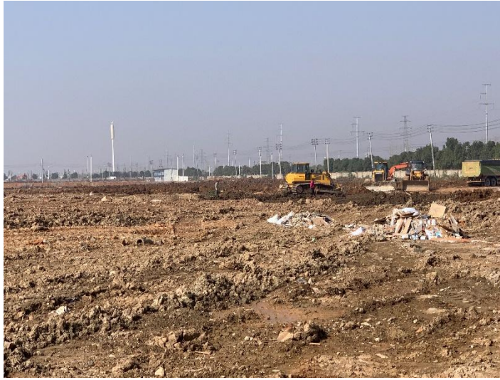
综合利用点照片
