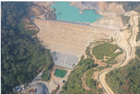
2021 年第四季度尾矿库边坡调查监测点
