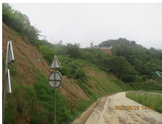
2022 年第一季度边坡植物措施调查监测点
