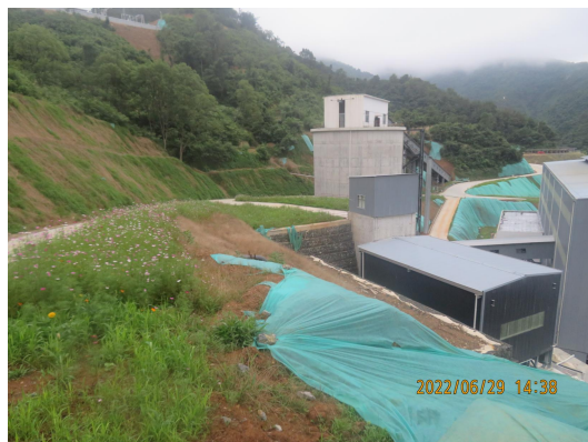
2022 年第二季度边坡植物措施调查监测点
