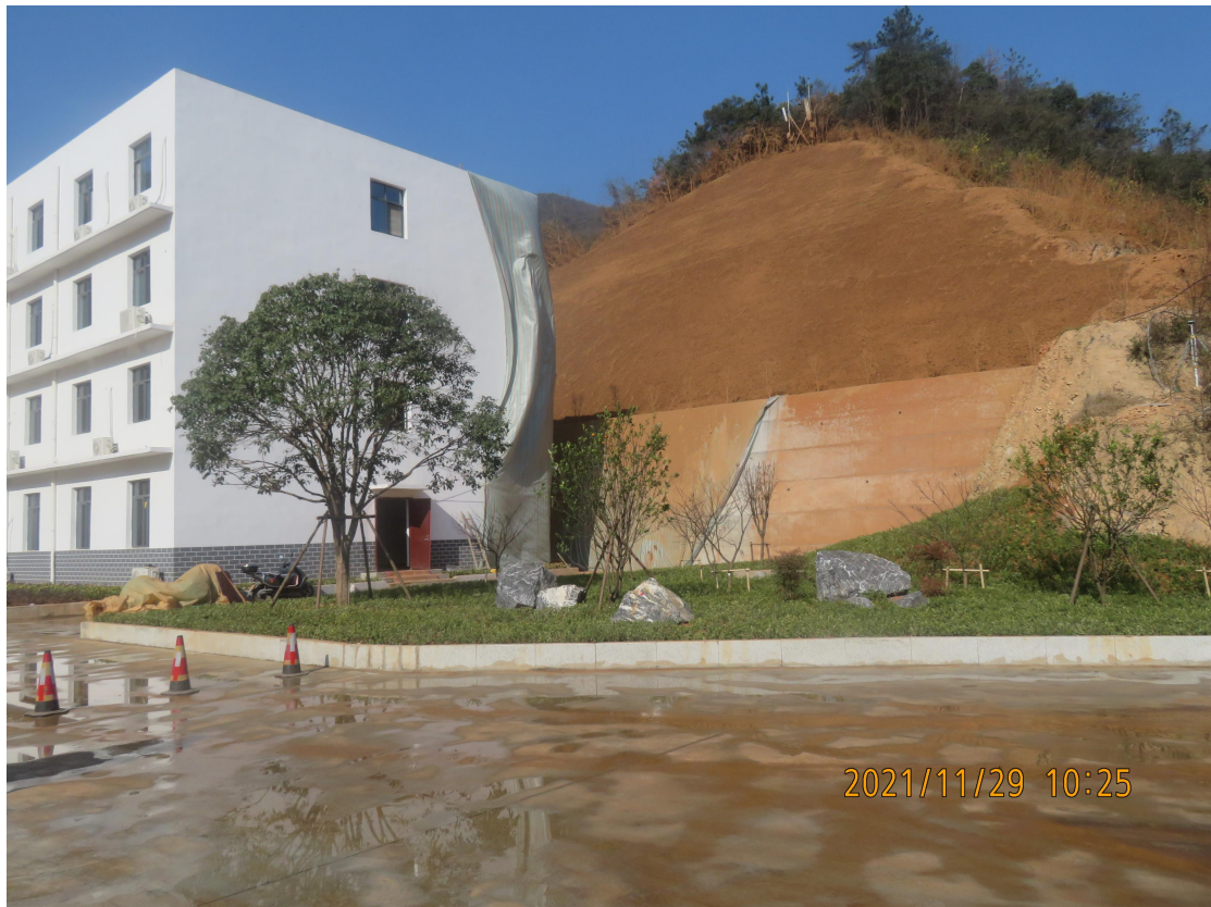
(施工过程中尾矿库及高陡边坡重点监测部位)
