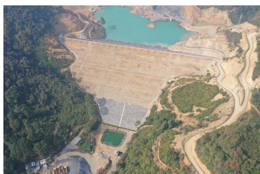
2021 年第四季度尾矿库边坡调查监测点
