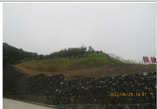
2022 年第二季度边坡植物措施调查监测点
