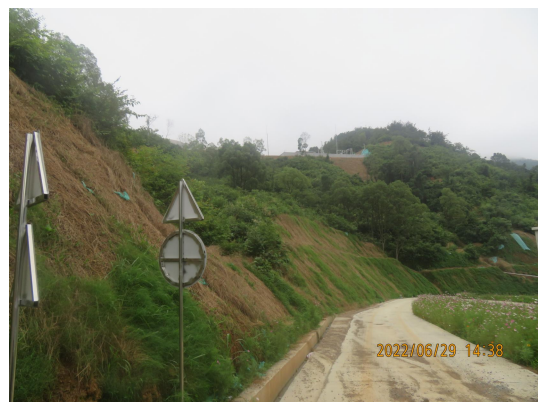
2022 年第一季度边坡植物措施调查监测点
