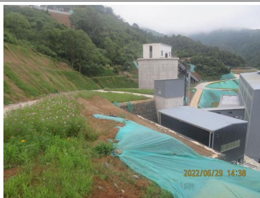
2022 年第二季度边坡植物措施调查监测点
