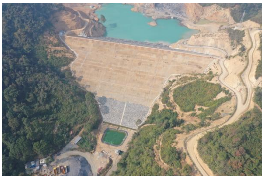
2021 年第四季度尾矿库边坡调查监测 点
