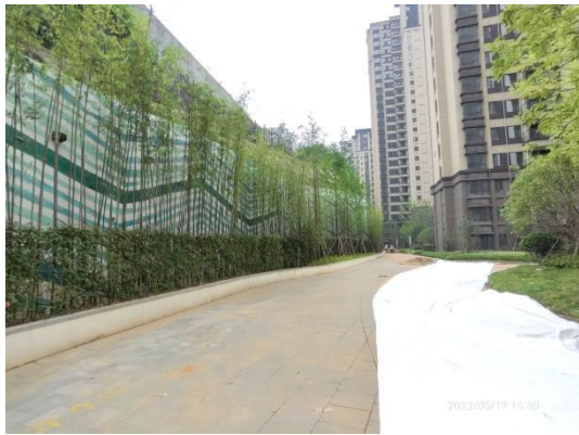
格构锚固护坡
