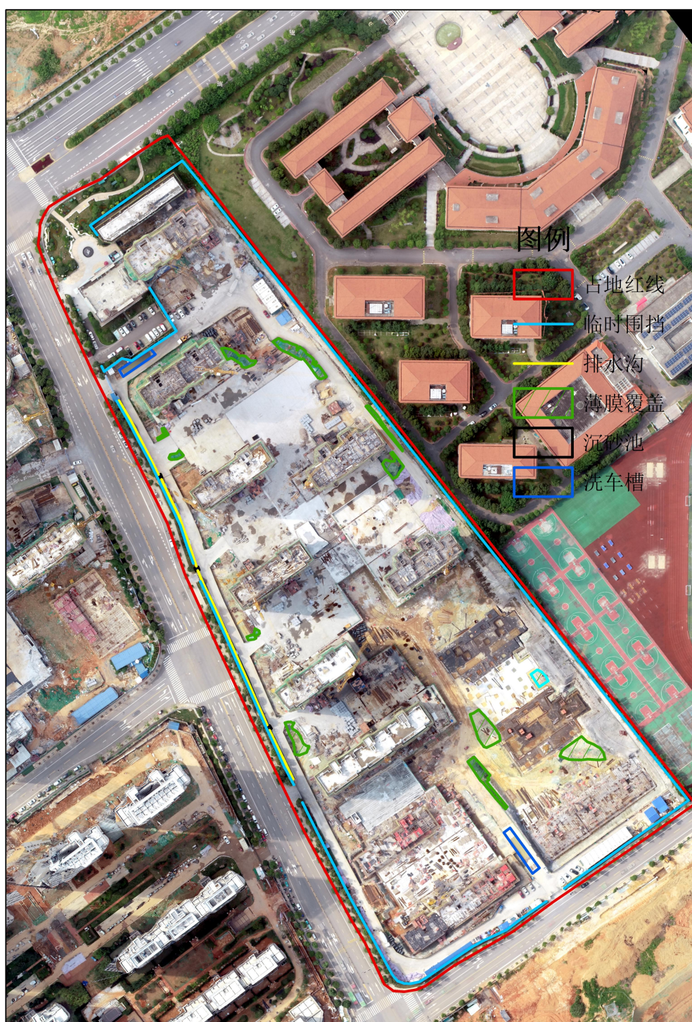
地下室开挖过程中影像
