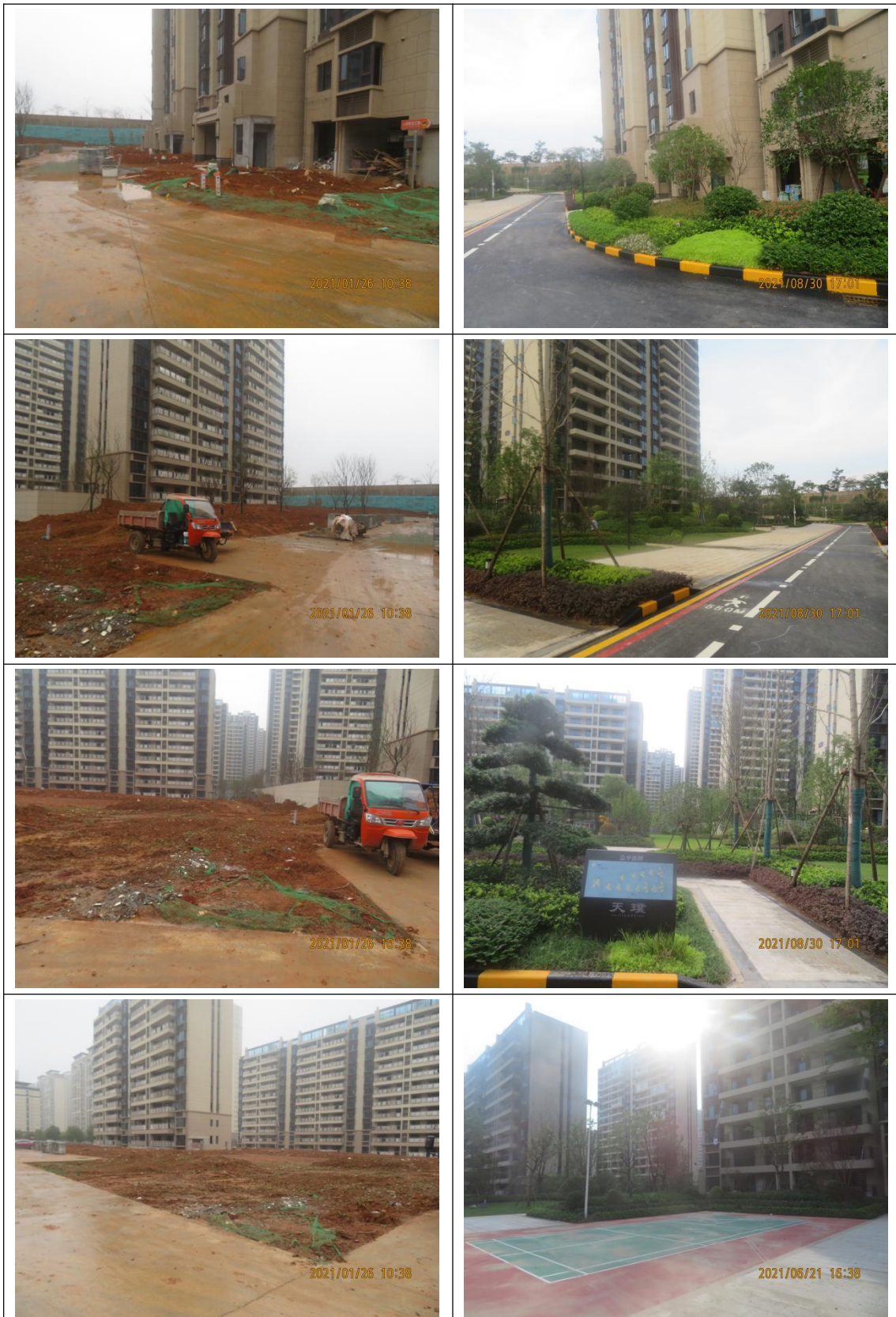
附件 6 重要水土保持单位工程照片
