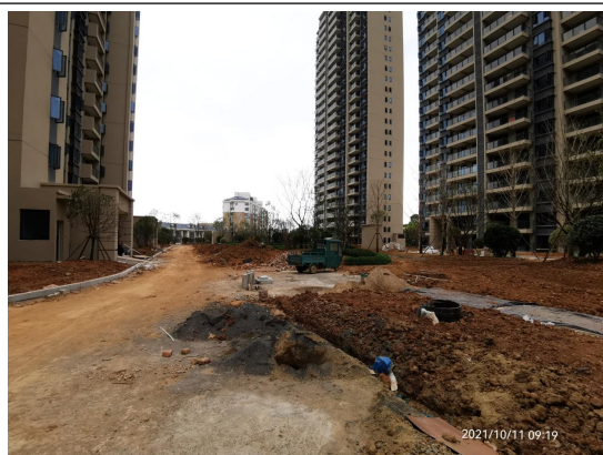
主体工程区监测过程中影像
