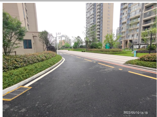
主体工程区完成措施影像
