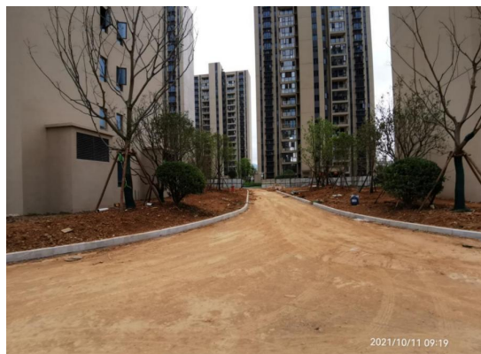
主体工程区监测过程中影像
