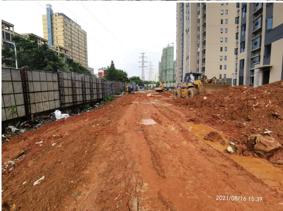
(施工过程中地下室开挖、回填及施工道路重点监测部位)
