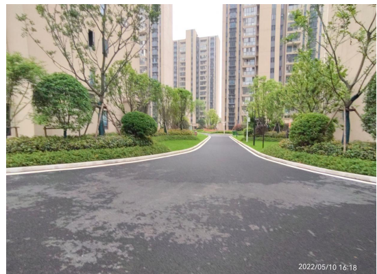
主体工程区完成措施影像
