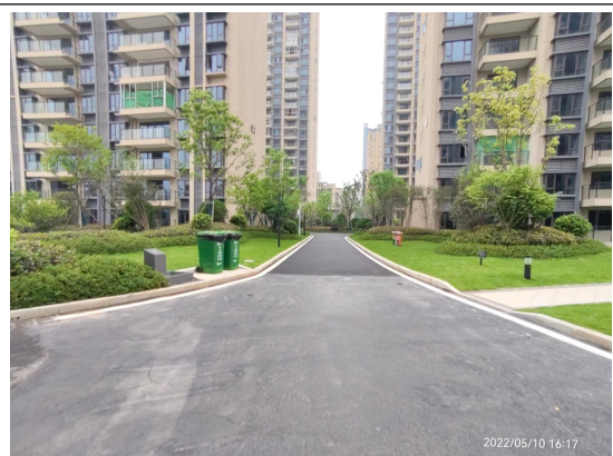
主体工程区完成措施影像
