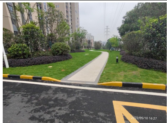
主体工程区完成措施影像
