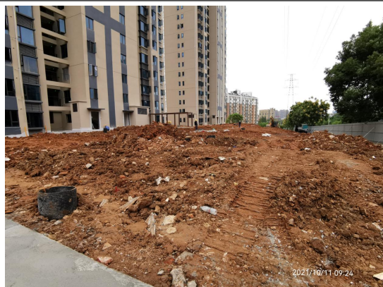
主体工程区监测过程中影像
