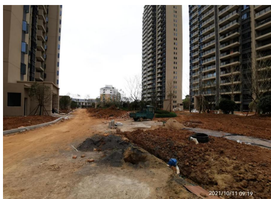
主体工程区监测过程中影像
