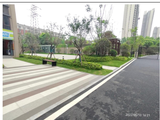
主体工程区完成措施影像
