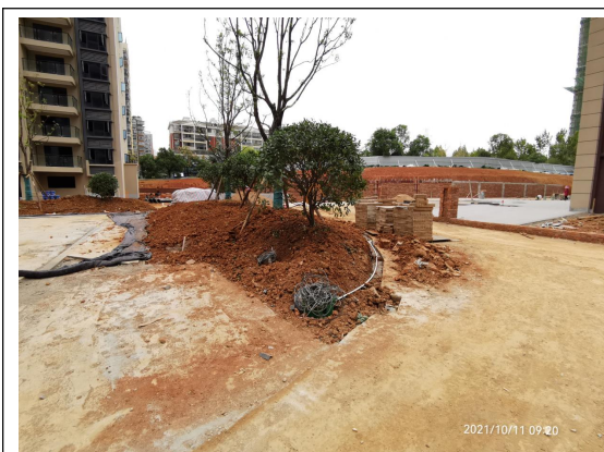
主体工程区监测过程中影像
