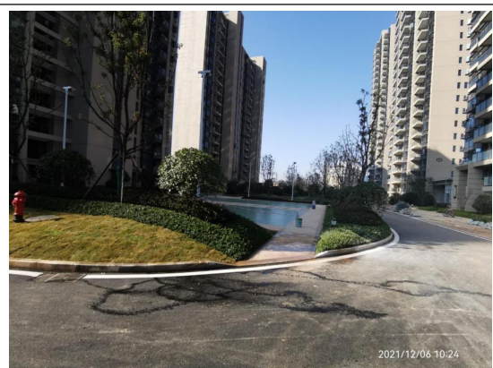
主体工程区完成措施影像
