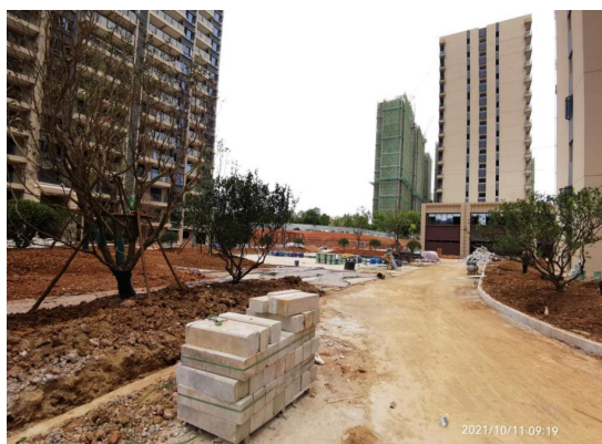
主体工程区监测过程中影像
