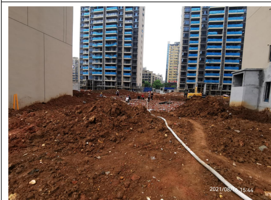
主体工程区监测过程中影像
