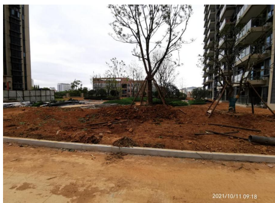
主体工程区监测过程中影像
