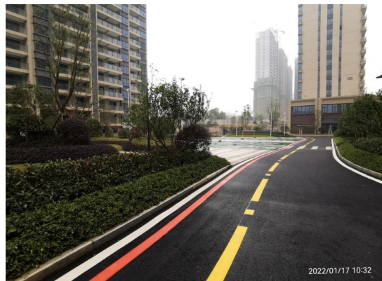
主体工程区完成措施影像
