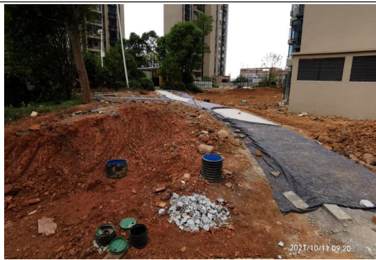
主体工程区监测过程中影像
