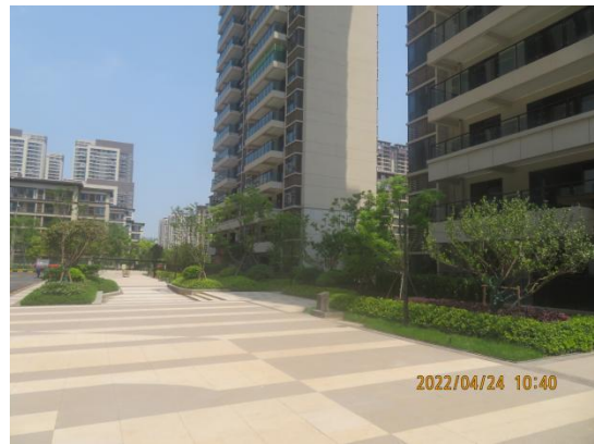
完成措施影像
