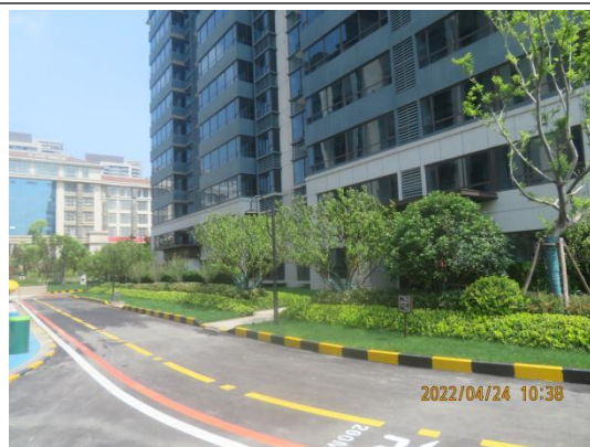
完成措施影像
