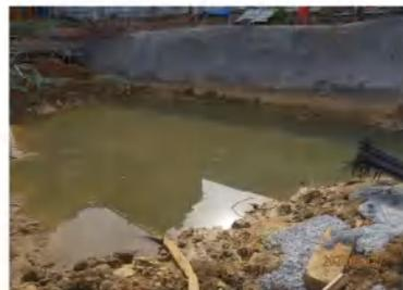
建议尽快得基坑, 场内的积水排出, 避免因其制约的工程进度
