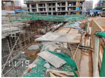
项目区基坑降水沟角未封闭, 建议施工单位及时封闭、清理
