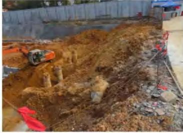
建议对项目区进行临时堆土采取防护措施，避免在对侧裸露产尘的水土流失
