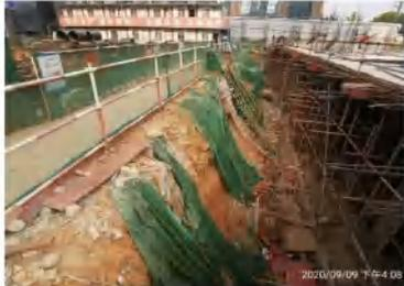
项目区内基坑应设置挡土及排水措施，避免产生新的水土流失
