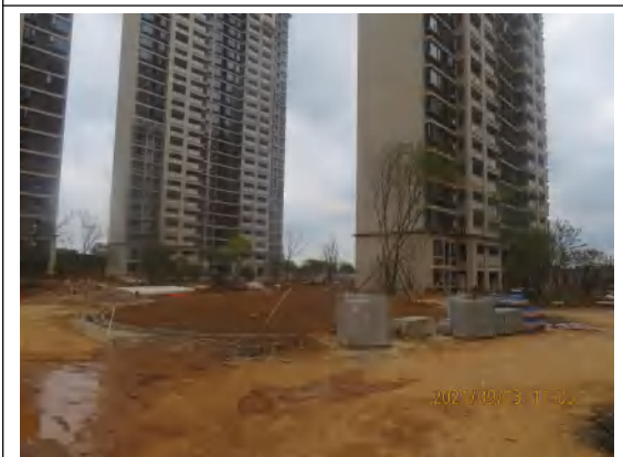
主体工程区监测过程中影像
