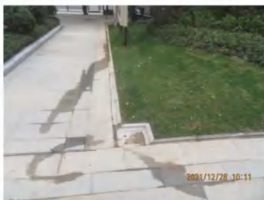
雨水口运行情况
