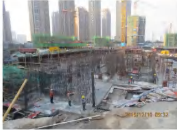
主楼框架建筑
