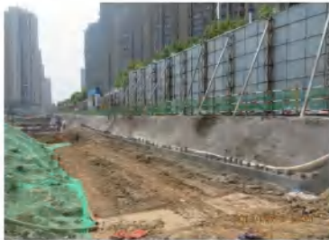
边坡支护建设
