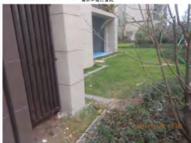
排水沟运行情况
