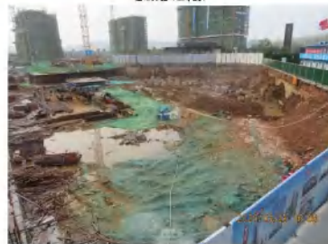
基坑开挖（下半度）
