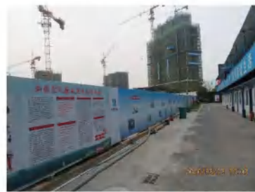
临时道路及洗车槽
