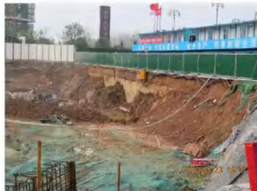
土方工程建筑（上季度）
