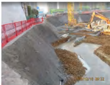
基坑开挖及支护工程（上半度）
