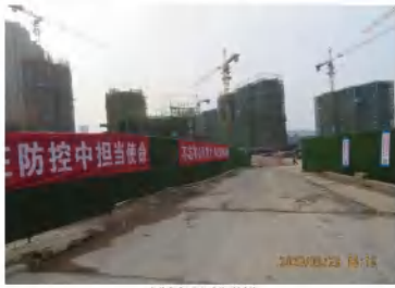
生活区配套设施及临时道路
