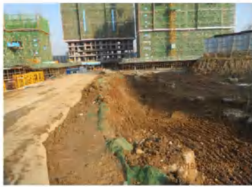
基础开挖（上季度）
