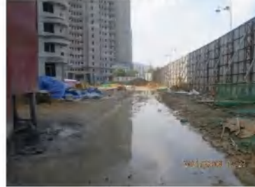
排水沟建设（本季度）
