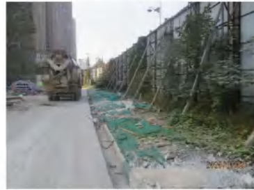
道路硬化及绿化排水沟（上季度）
