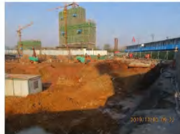
基坑开挖（上半度）
