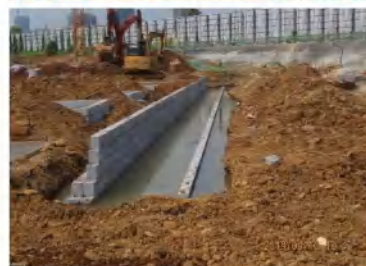
建设单位未按设计、监理单位工程竣工
