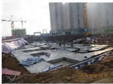
基础工程建筑
