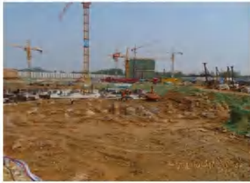
主体建筑建设
