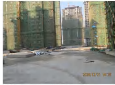
主体框架建设
