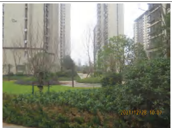
主体工程区完成措施影像
