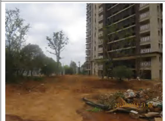
主体工程区监测过程中影像
