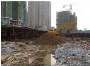
土方工程建筑（上季度）
