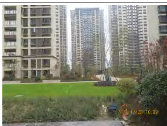
主体工程区完成措施影像
