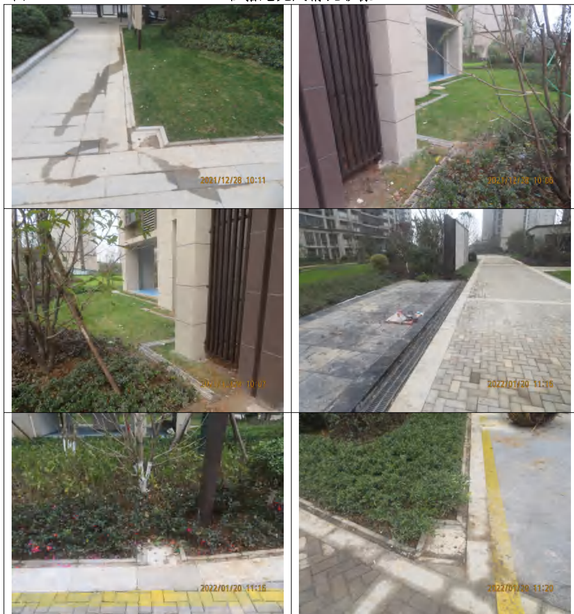
图 4.1-1 工程措施完成情况影像
