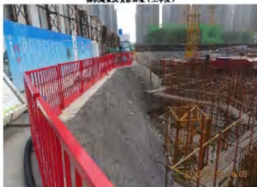
基坑开挖及支护工程（下半度）
