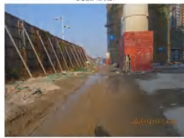
排水沟及道路（上半年度）
