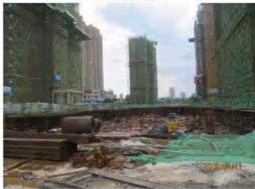
土方工程建筑（本季度）
