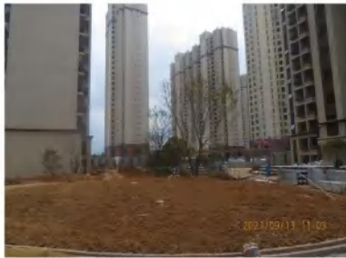
(该地为回填土方裸露，建议尽快进行绿化工程)
