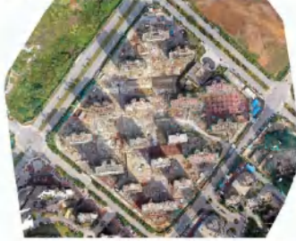
主体建设前（2020年9月）
