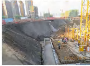
排水沟及边坡加固工程
