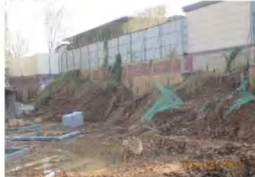
项目区内开挖边坡裸露，建议采取临时防护措施，减少水土流失
