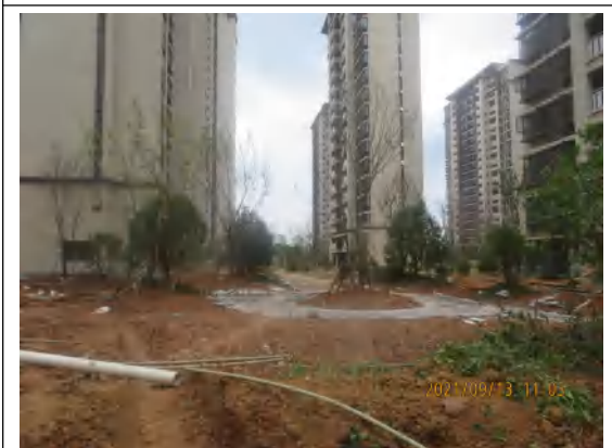
主体工程区监测过程中影像
