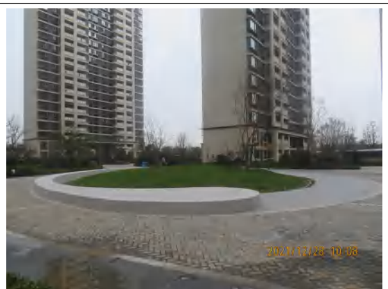
主体工程区完成措施影像
