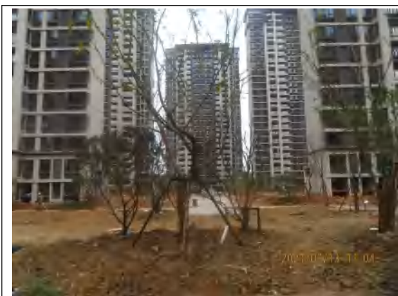
主体工程区监测过程中影像
