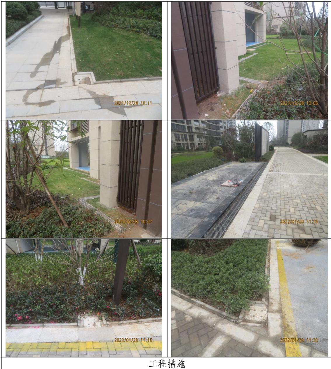
附件 6 重要水土保持单位工程照片
