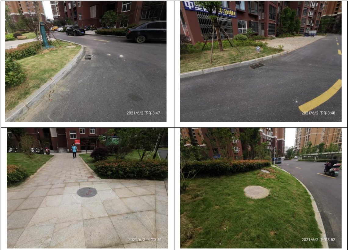
雨水井雨水口运行情况
