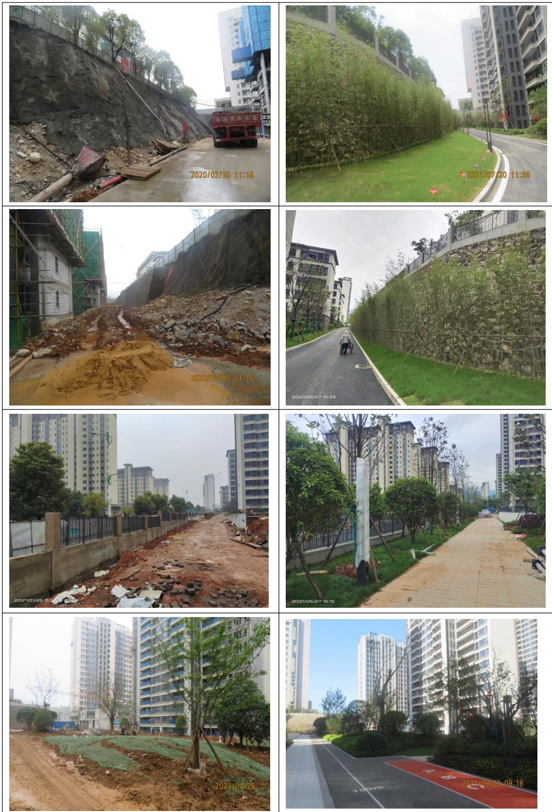
附件 7 重要水土保持单位工程照片
