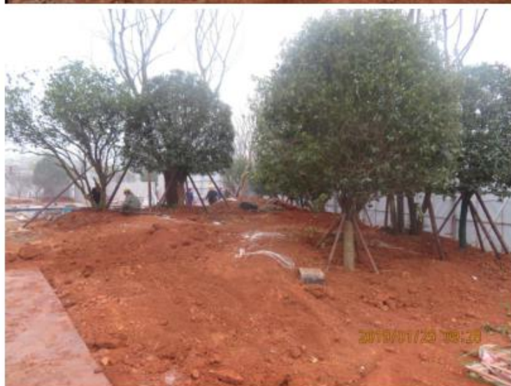
施工前期剥离表土及利用情况
