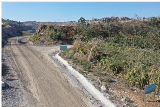
矿区道路排水沟
