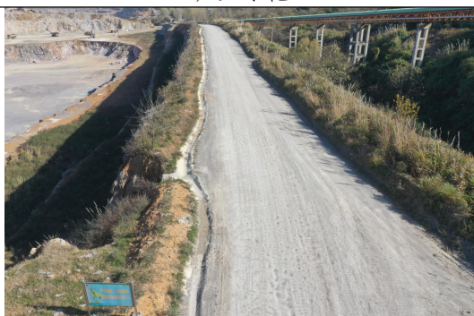
矿区道路排水沟
