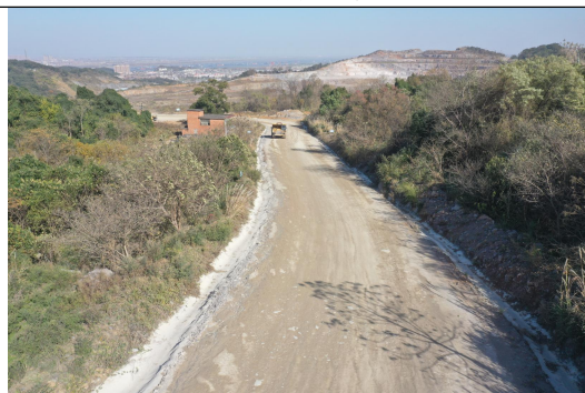
矿区道路排水沟
