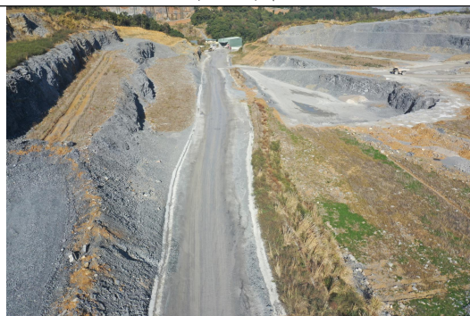
矿区道路排水沟
