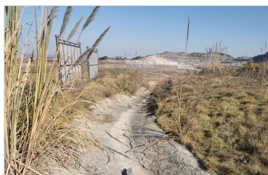
矿区道路排水沟
