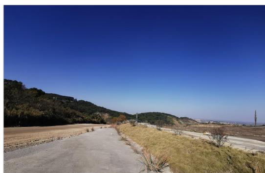
矿区道路排水沟
