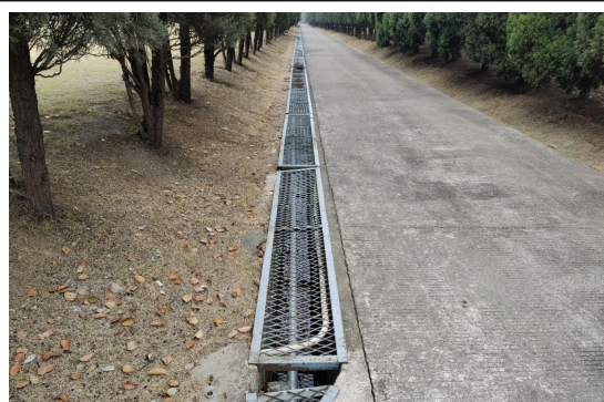
厂区道路排水沟
