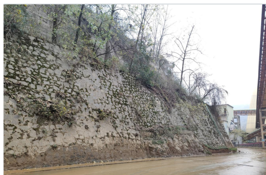
厂区浆砌石与砼护坡
