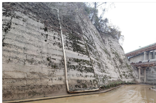
厂区浆砌石与砼护坡
