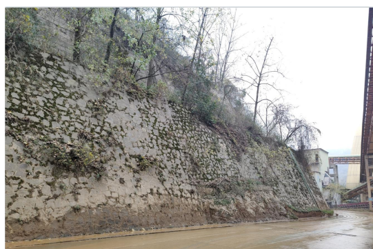
厂区浆砌石与砼护坡
