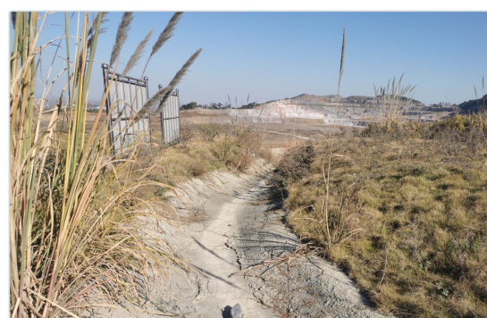
矿区道路排水沟
