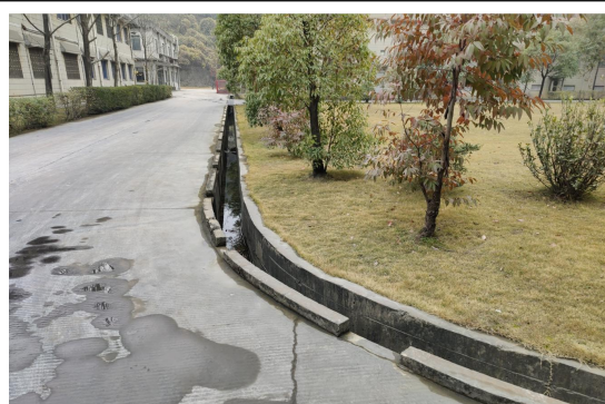
厂区道路排水沟
