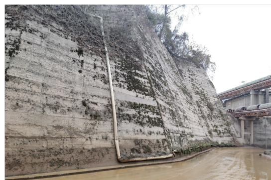
厂区浆砌石与砼护坡
