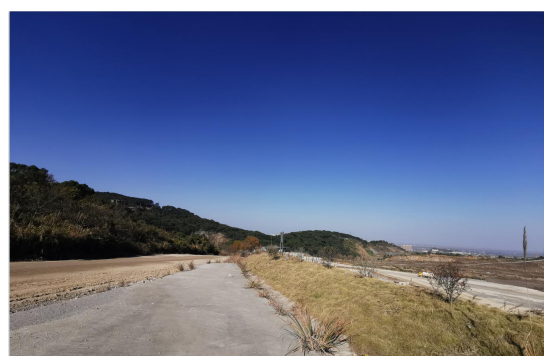
矿区道路排水沟
