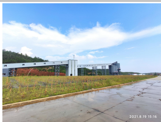
工业场地防治区撒播草籽
