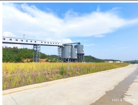
工业场地防治区撒播草籽
