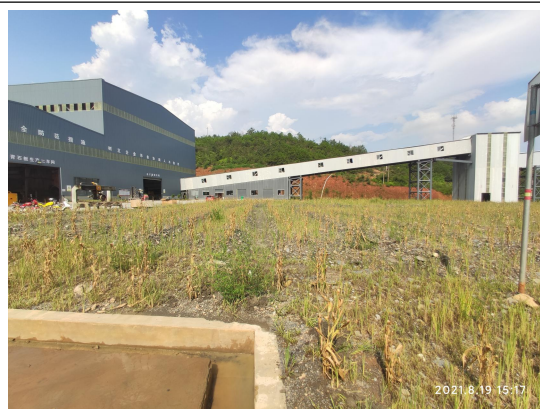
工业场地防治区撒播草籽
