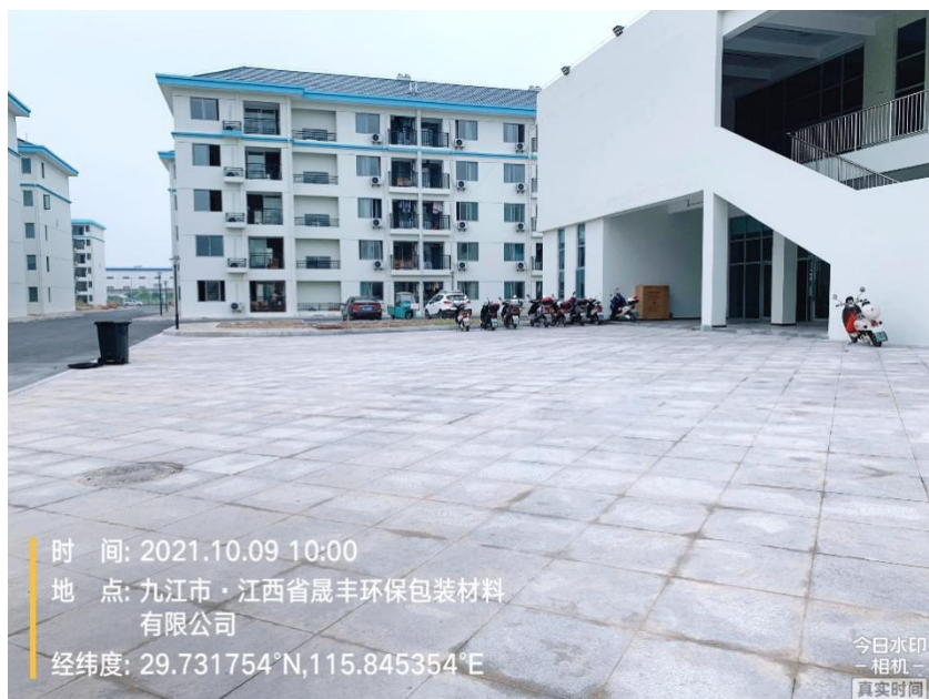
场地硬化现场照片
