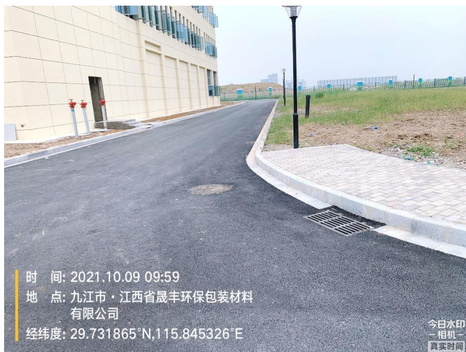
雨水井、雨水口现场照片
