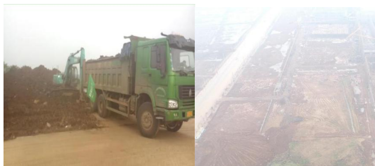
德宏工业项目地块（港兴路南侧）弃土点照片
