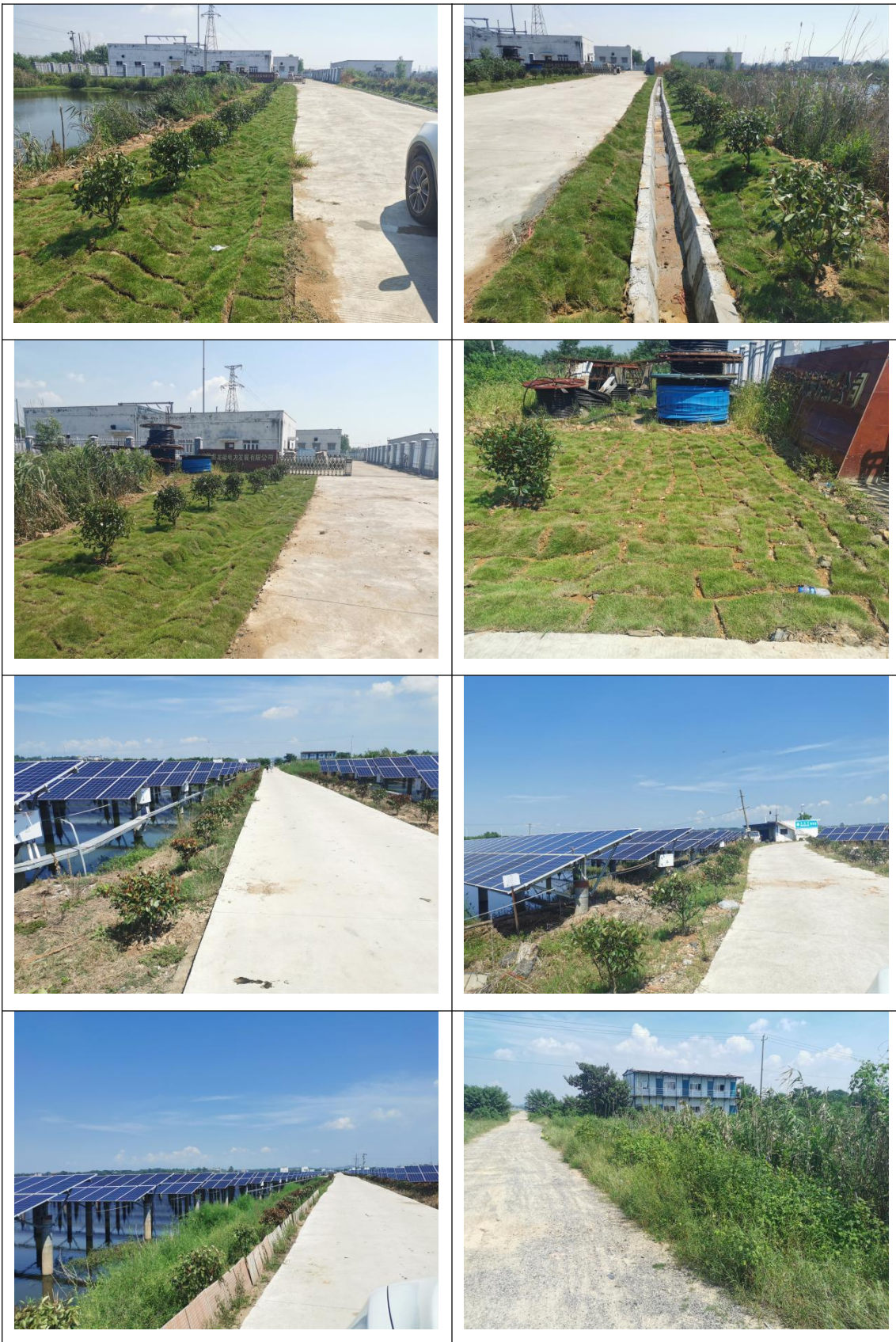
附件 6 重要水土保持单位工程照片
