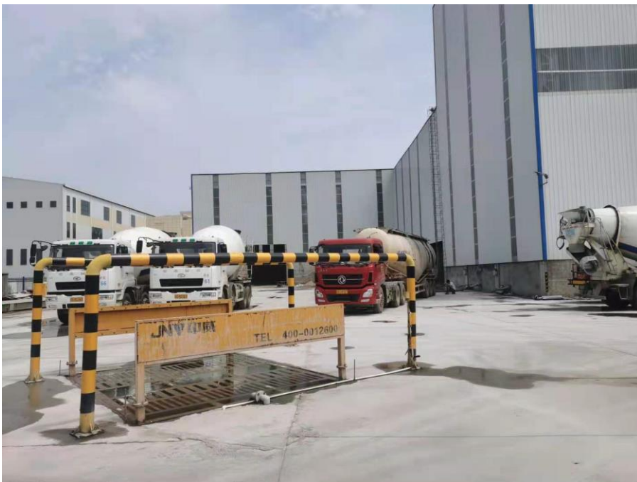
洗车槽现场照片
