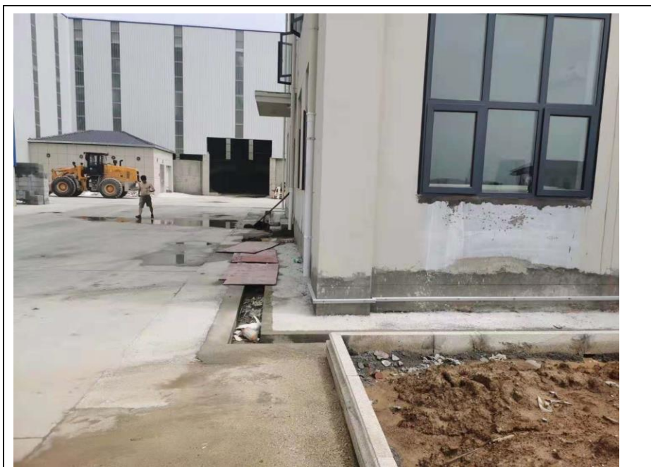
综合楼房前屋后排水沟现场照片
