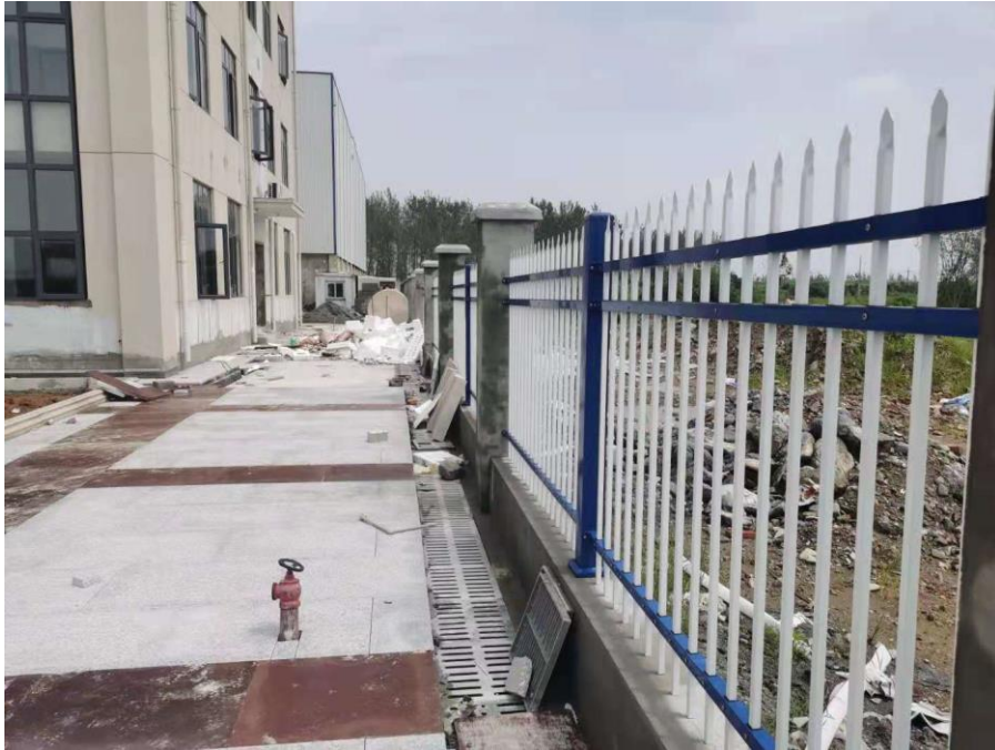
盖板沟现场照片
