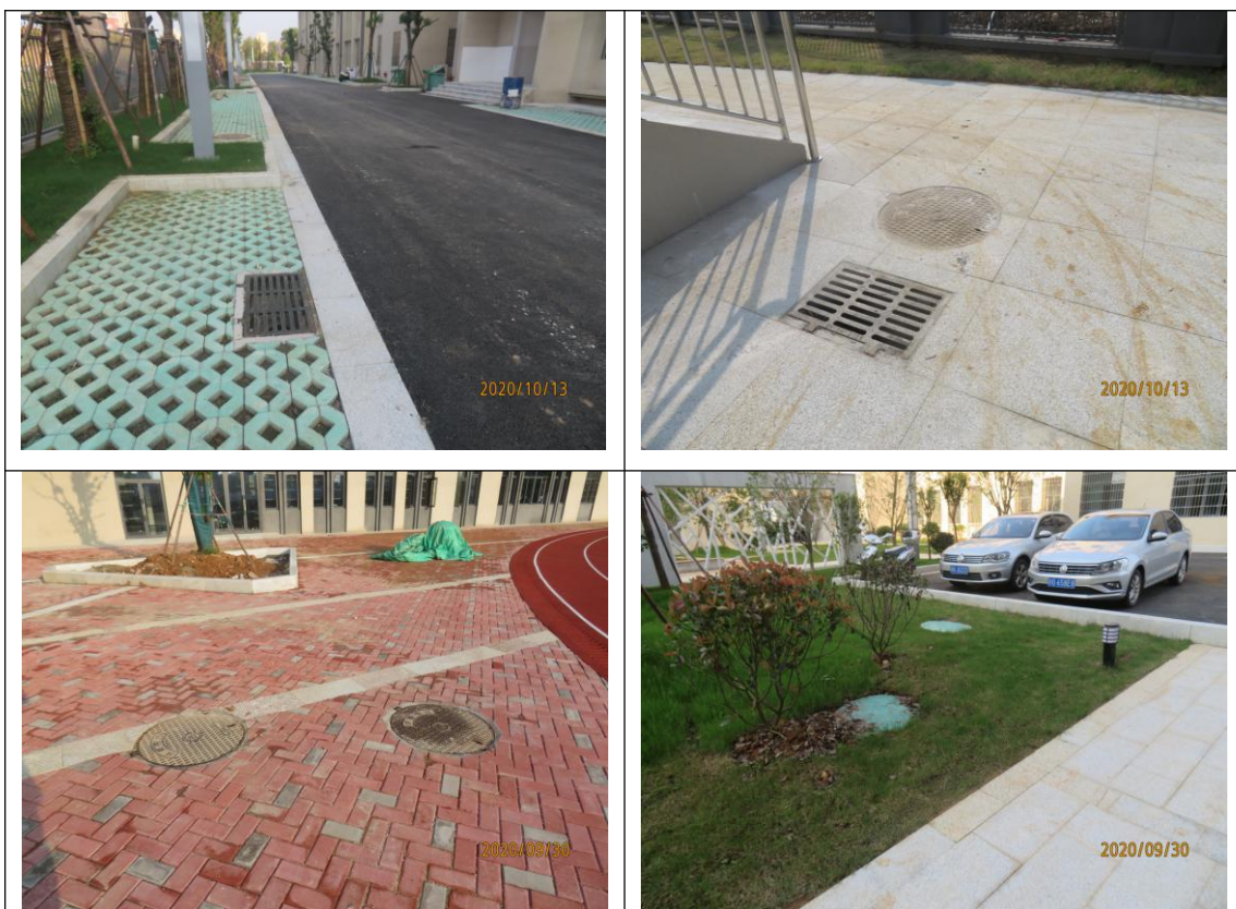
排水沟、雨水井雨水口运行情况
