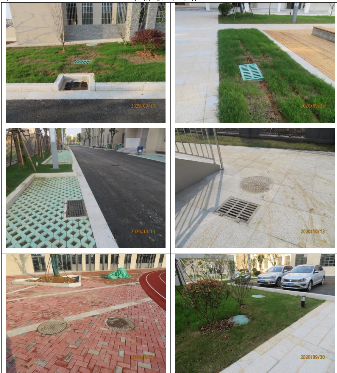
排水沟、雨水井雨水口运行情况
