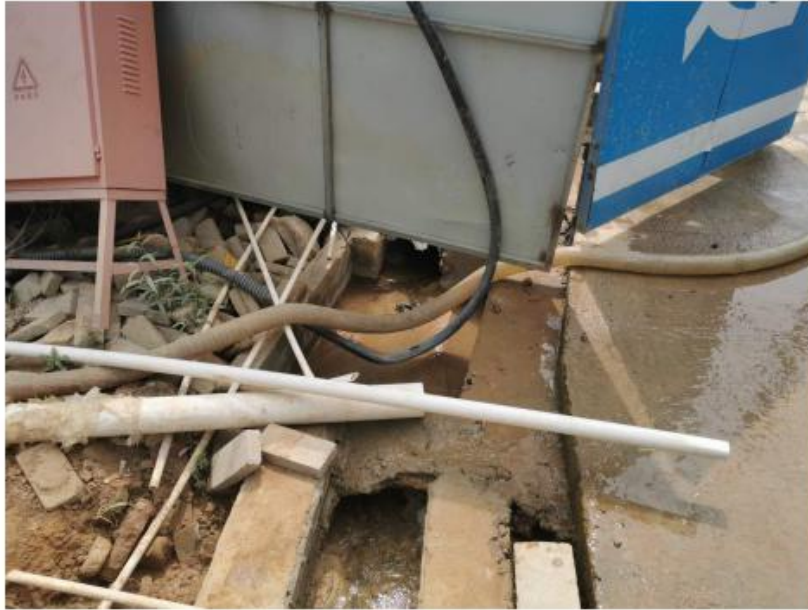
水土保持监测点（沉砂池）
