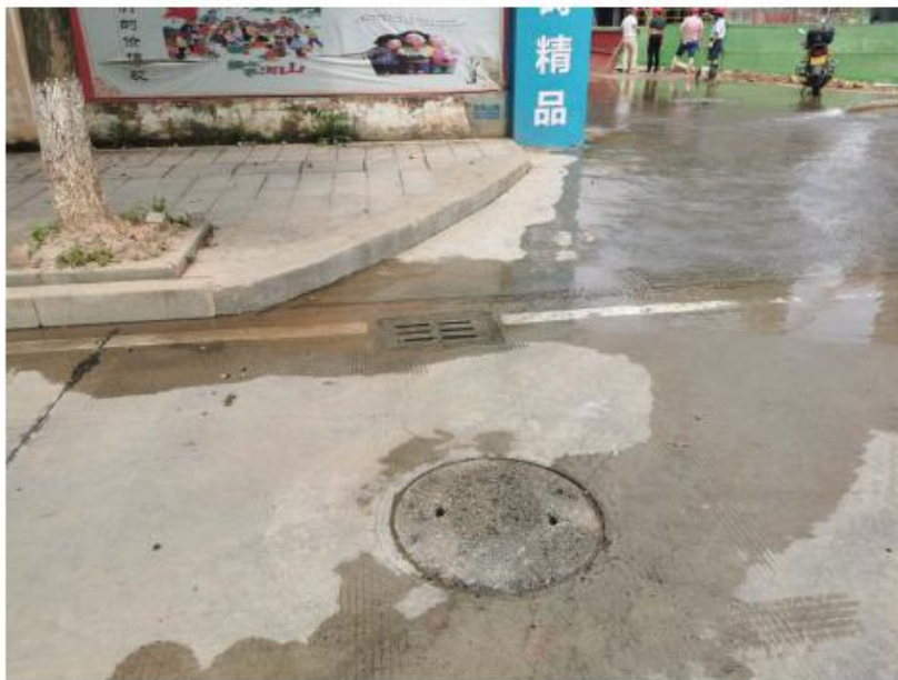
市政雨水口及雨水井
