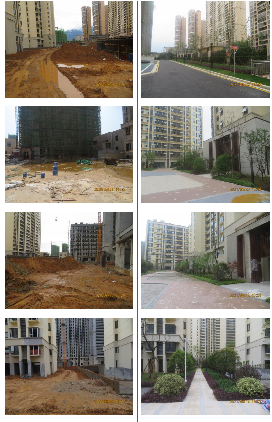
附件 7 重要水土保持单位工程照片
