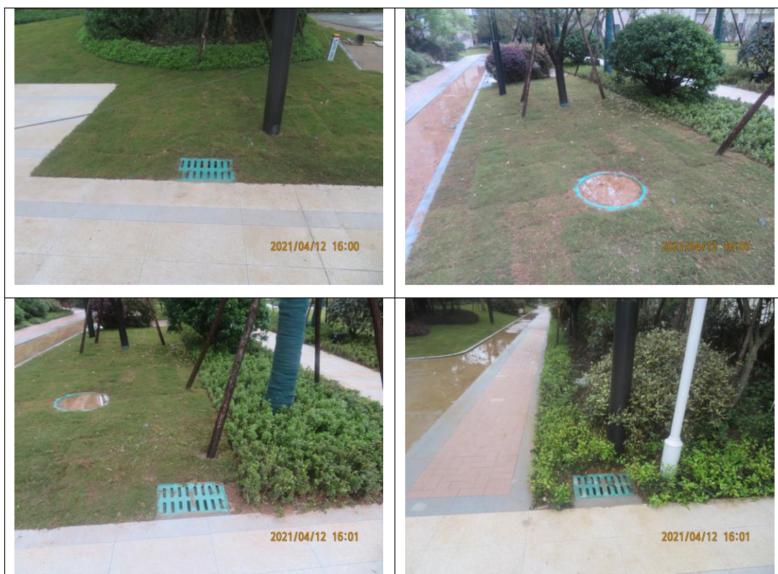
雨水井雨水口运行情况
