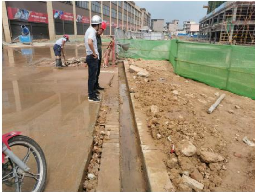
已完善部分场地内砖砌排水沟
