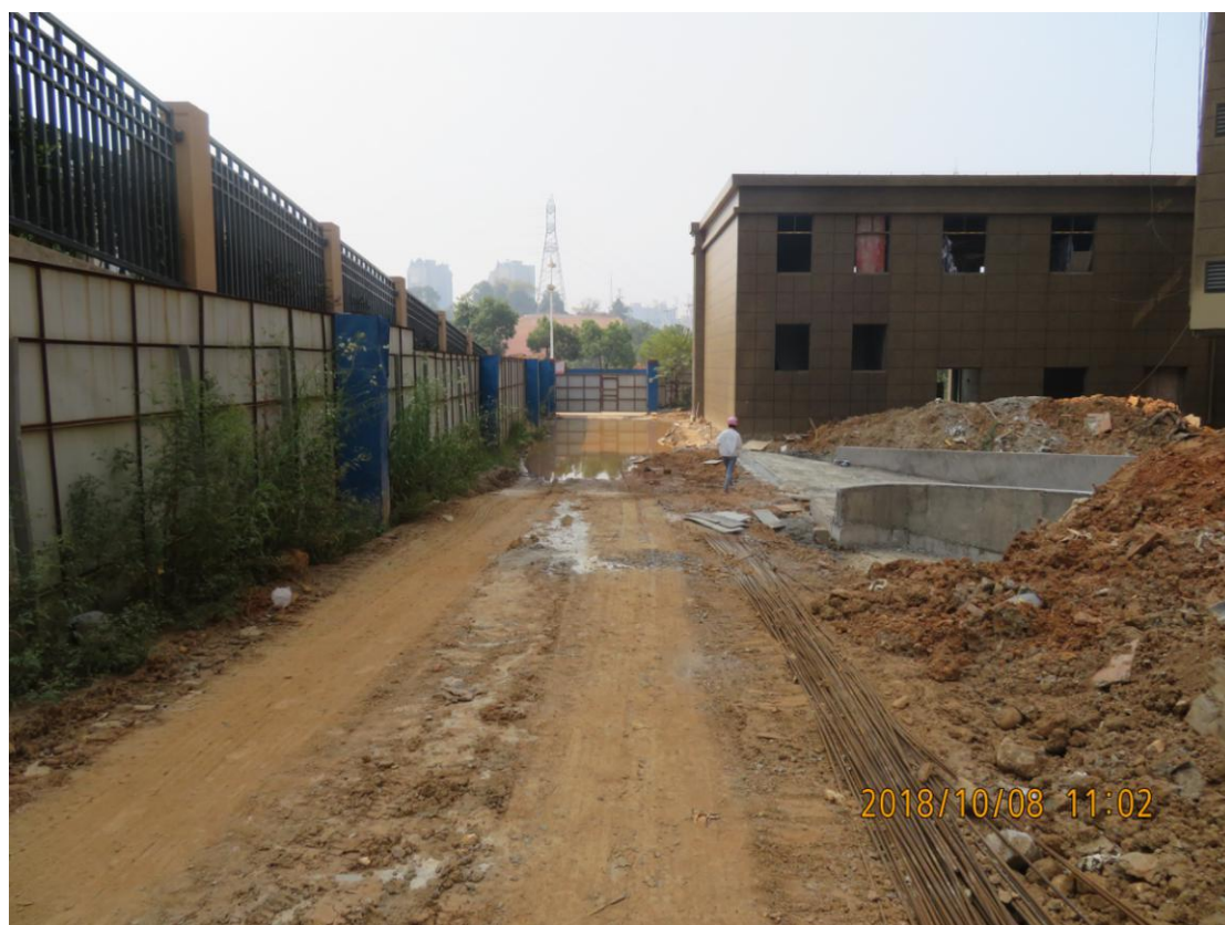
施工过程中临时围挡影像
