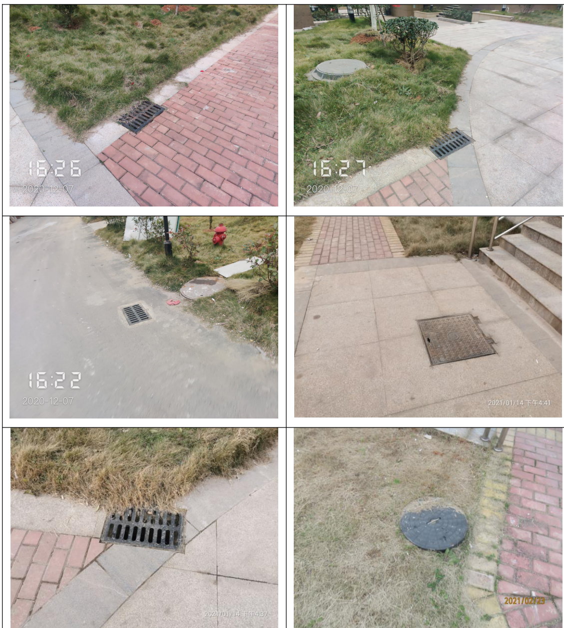
雨水井雨水口运行情况
