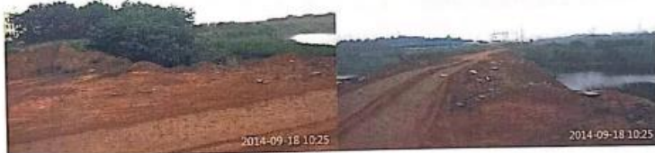
九江公路局用地施工现场
