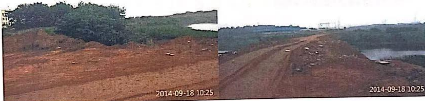
九江公路局用地施工现场
