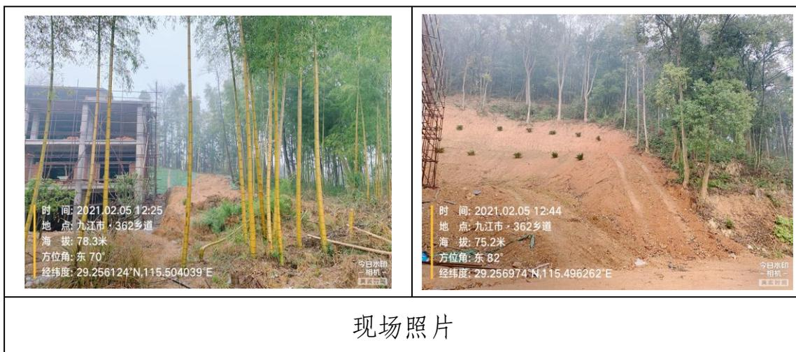
本项目原始场地起伏较大，娱乐中心原始标高介于 64.68~70.43m，场地设计标高为 65.20m，建筑物  $\pm 0.00$  标高为 65.50m；垂钓会所原始标高介于 65.27~67.84m，场地设计标高为 65.50m，建筑物  $\pm 0.00$  标高为 65.80m；VIP 客房及员工中心原始标高介于 64.99~73.90m，场地设计标高为 68.70~69.70m，建筑物  $\pm 0.00$  标高为 69.00m、70.00m。场地与周边存在高差区域均采用植物护坡。
