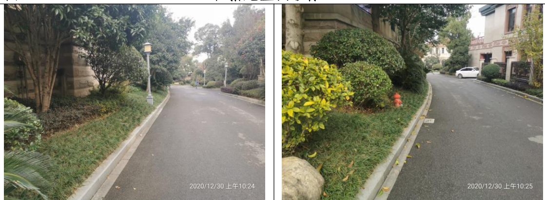
工程措施运行情况
