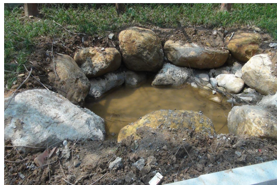
临时生态沉砂池
