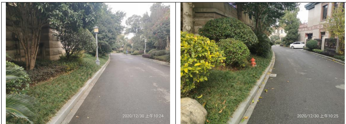
工程措施运行情况
