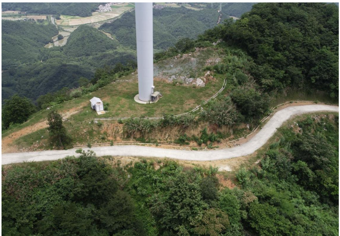
风机平台边坡及排水措施运行情况
