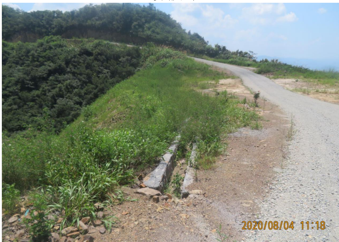
弃土场截水沟
