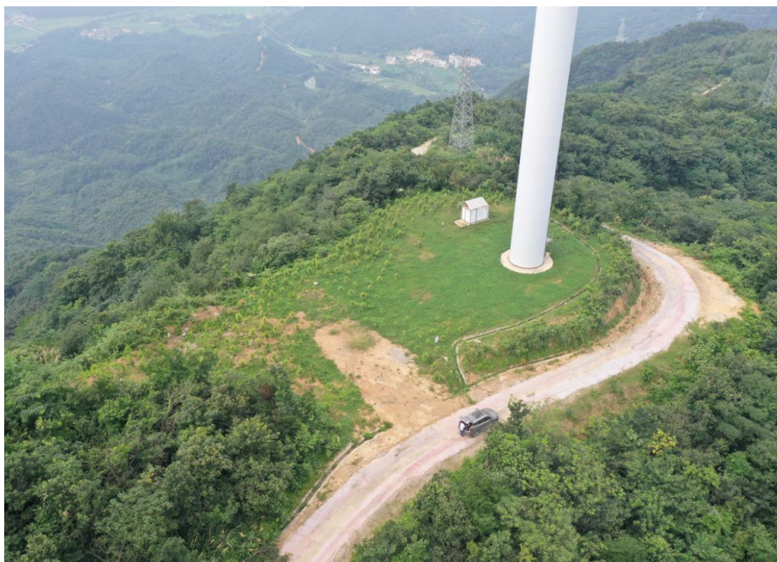
风电机组截、水沟运行情况 2020 年 7 月
