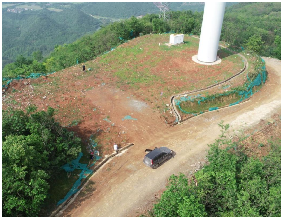
风电机组截、水沟运行情况 2019 年 4 月
