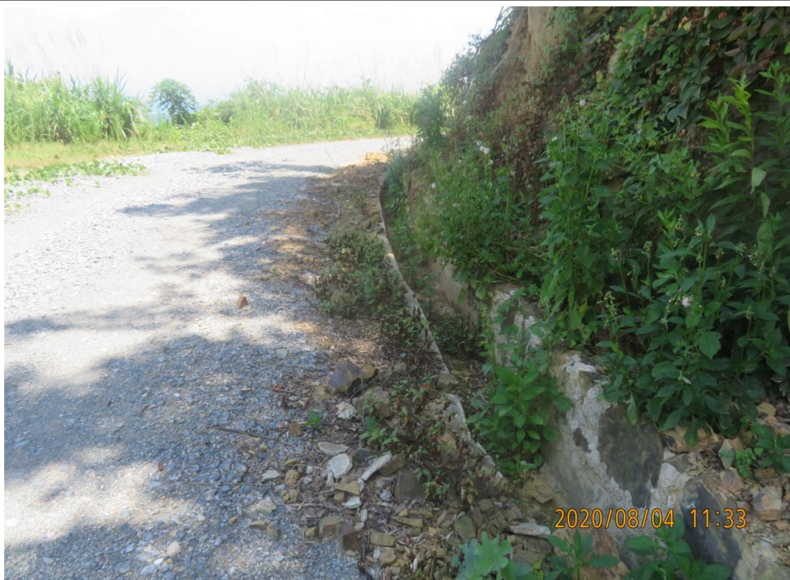
道路排水沟完成情况
