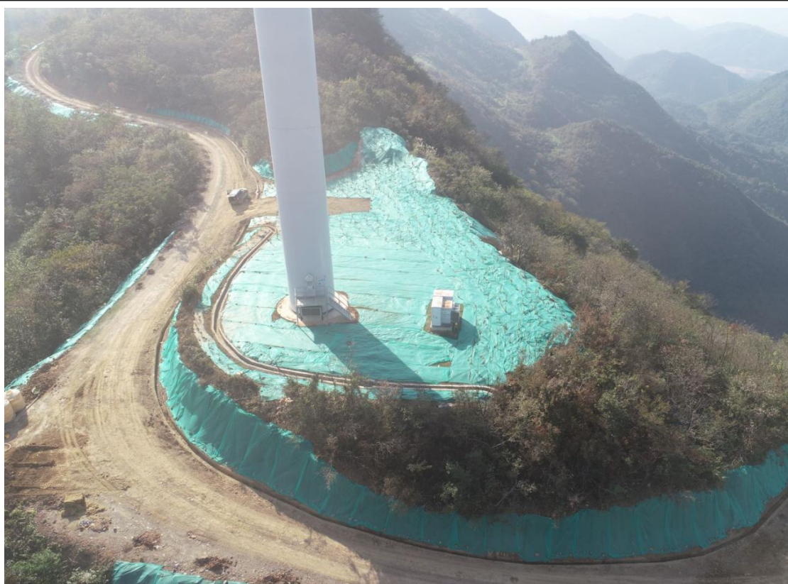
风电机组边坡现状 2018 年 11 月
