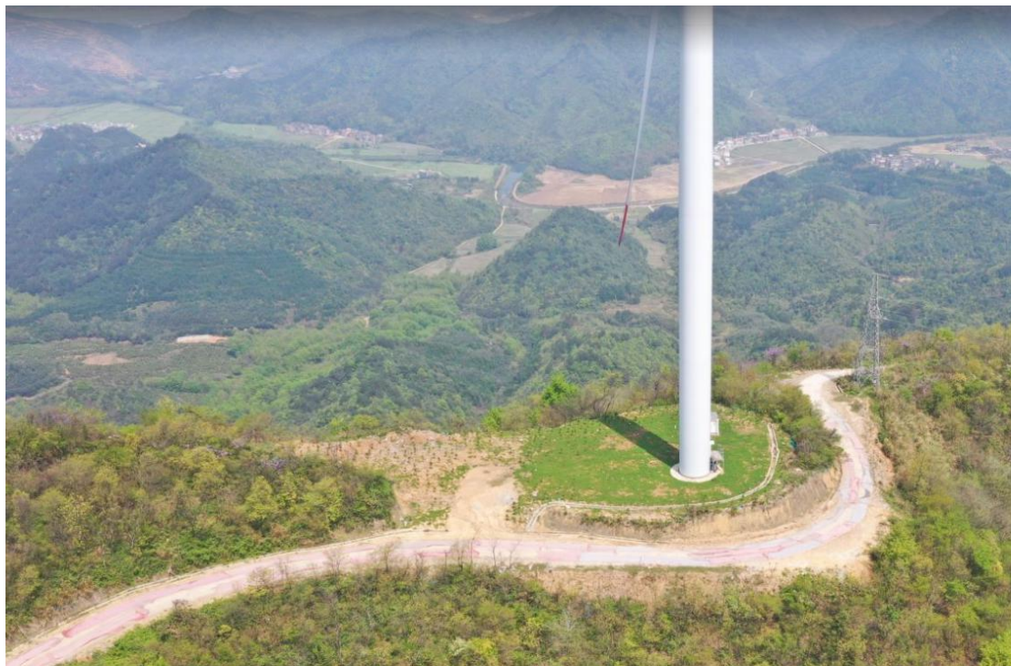
风电机组截、水沟运行情况 2020 年 4 月
