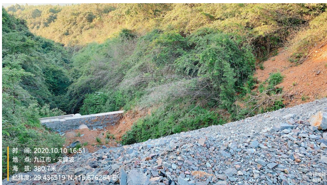
380m 平硐采矿工业场地边坡照片
