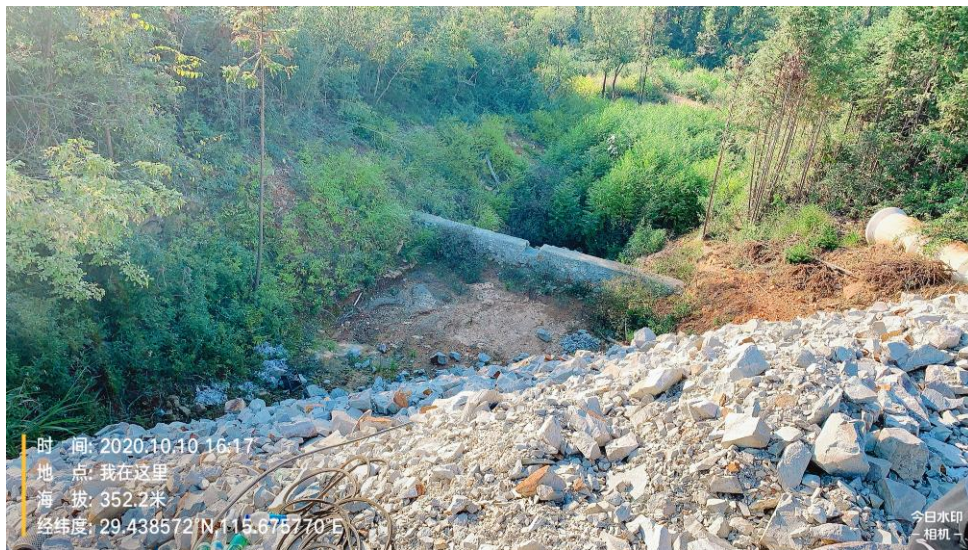
360m 平硐采矿工业场地边坡照片
