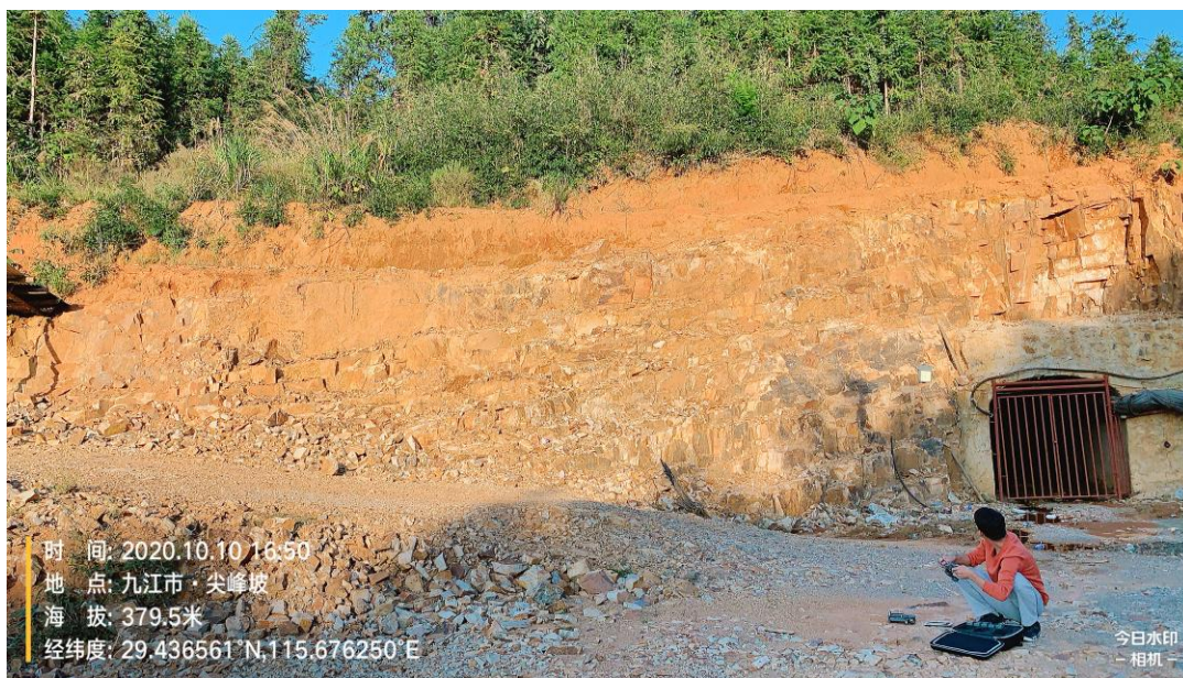
380m 平硐上方三级放坡照片
