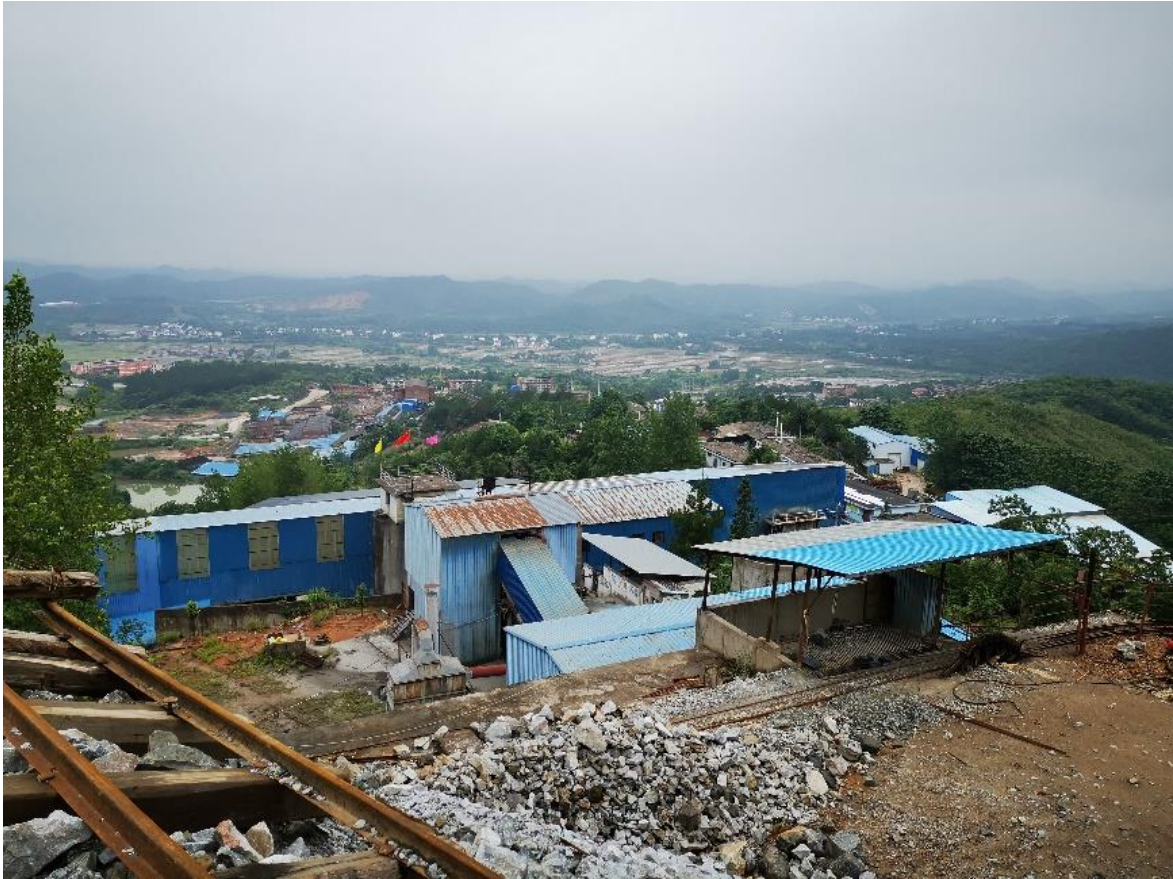
选矿工业场地俯视照片
